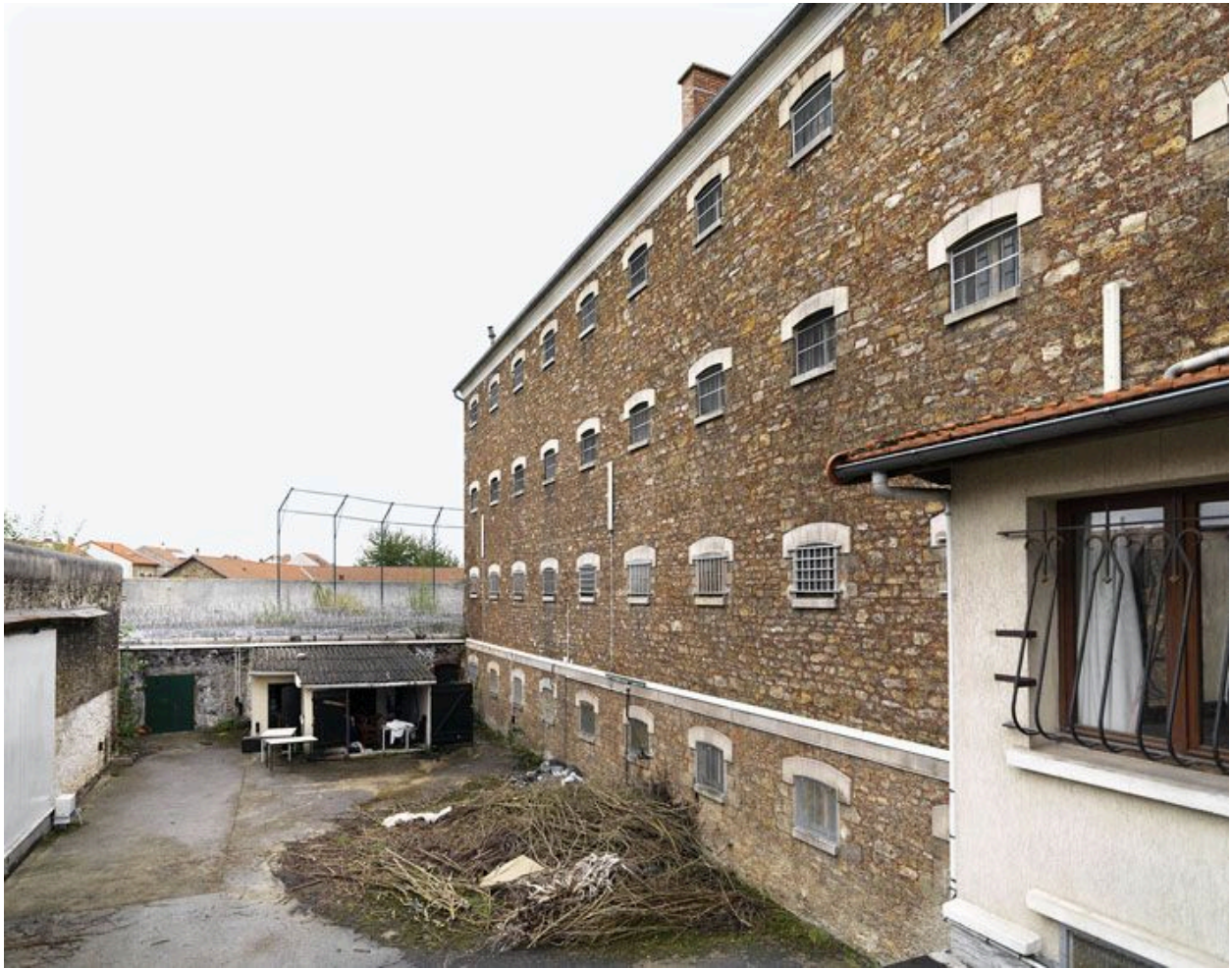
Élévation nord du bâtiment cellulaire, vue depuis le nord-ouest.
