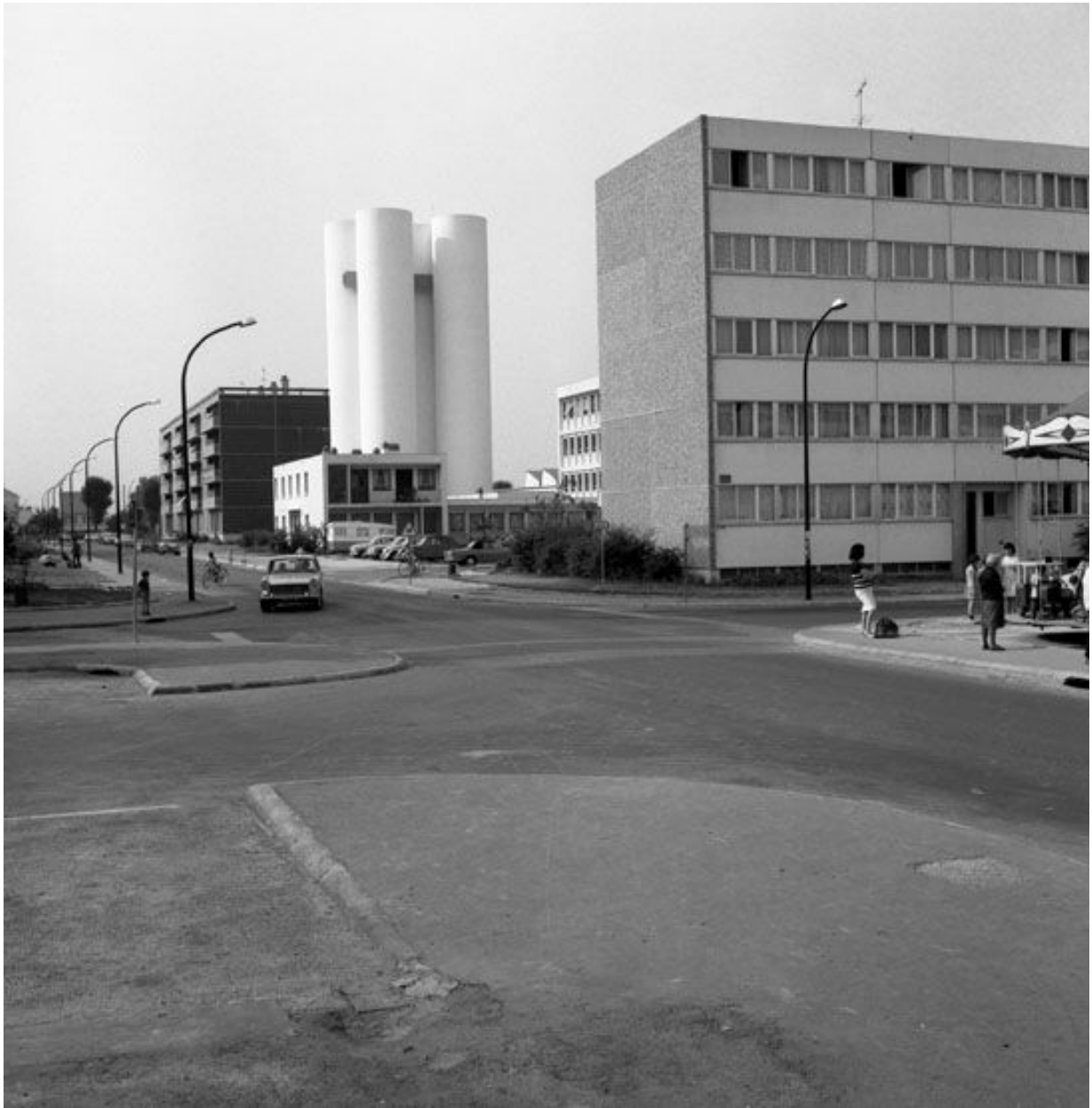
Les barres B, D et du château d'eau depuis l'avenue du Président Kennedy. Photographie, 1966. (Ministère de l'Ecologie, MRU 43749)
