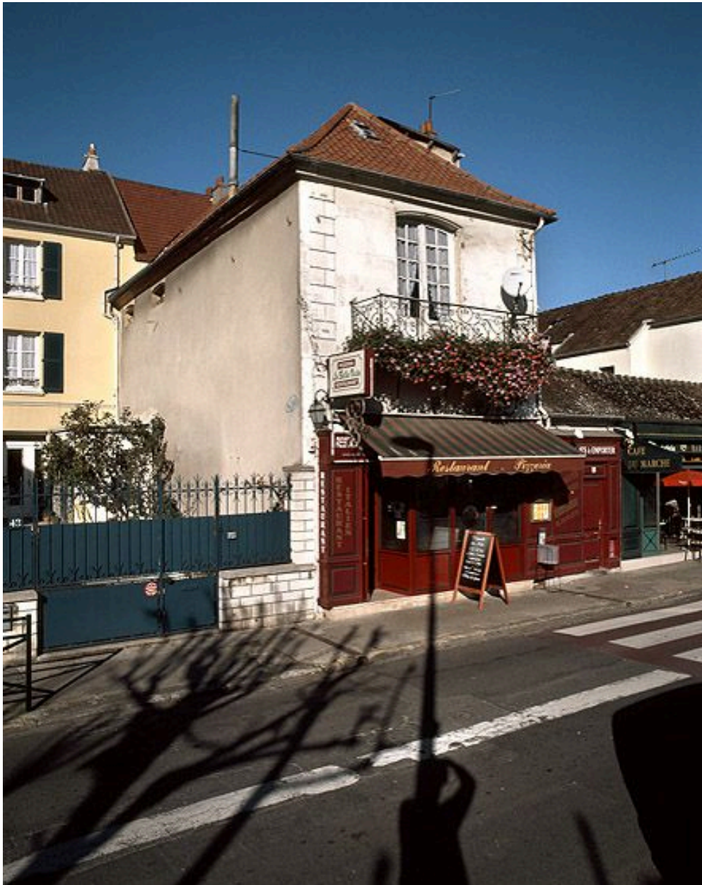
Façade donnant sur la Seine et façade latérale.
