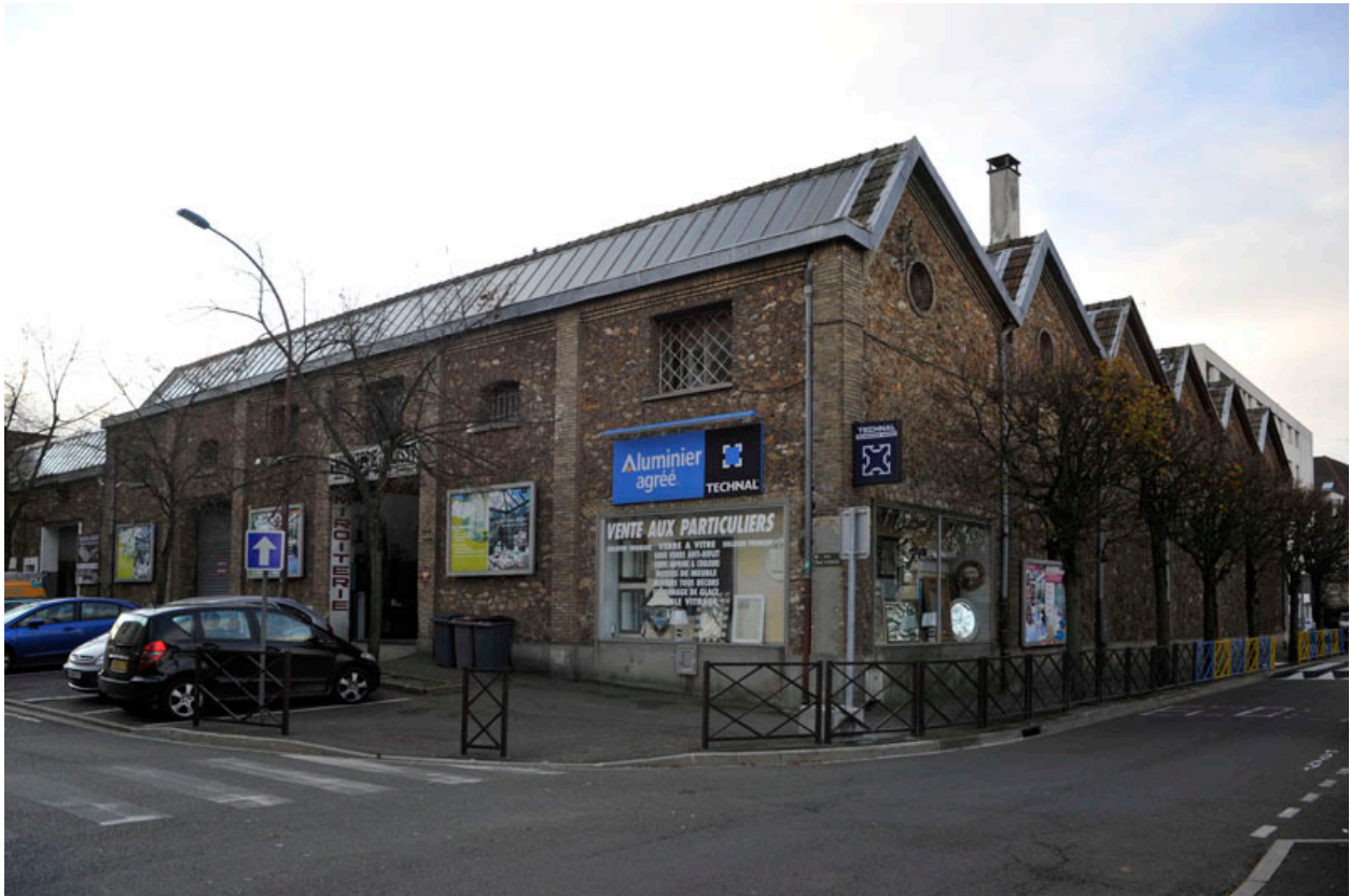
Poissy, usine, actuellement atelier Miroiterie de Poissy et supermarché Franprix, angle 16 boulevard Devaux et 2 rue Paul Codes. Entrée de l'atelier Miroiterie de Poissy, rue Paul Codos.
