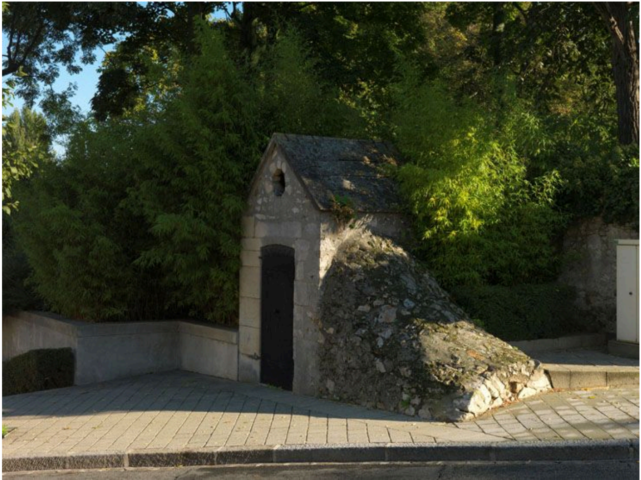
Rungis, Lucien Grelinger (avenue). Regard de la Pirouette avec #illeton d'aération.
