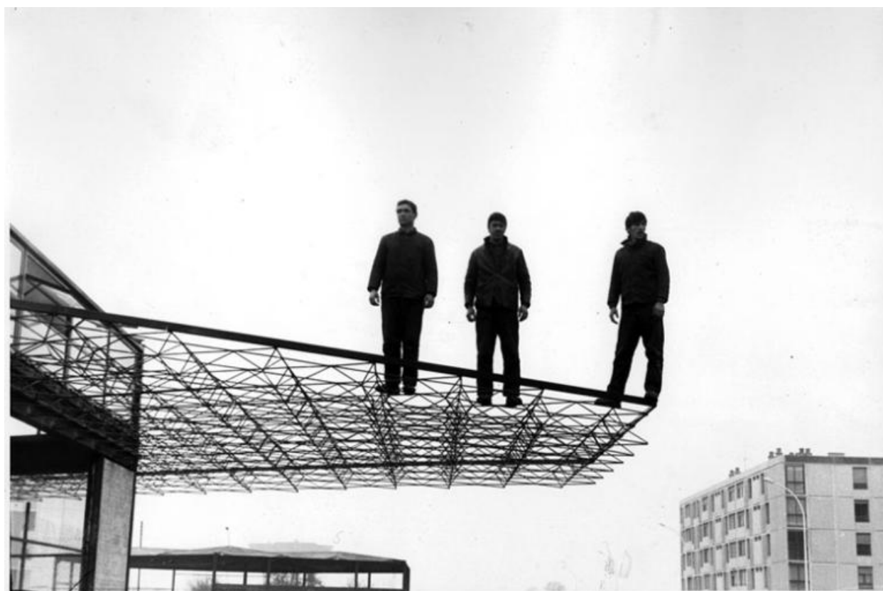
Vue de la construction : détail de la charpente métallique avec trois ouvriers du chantier.
