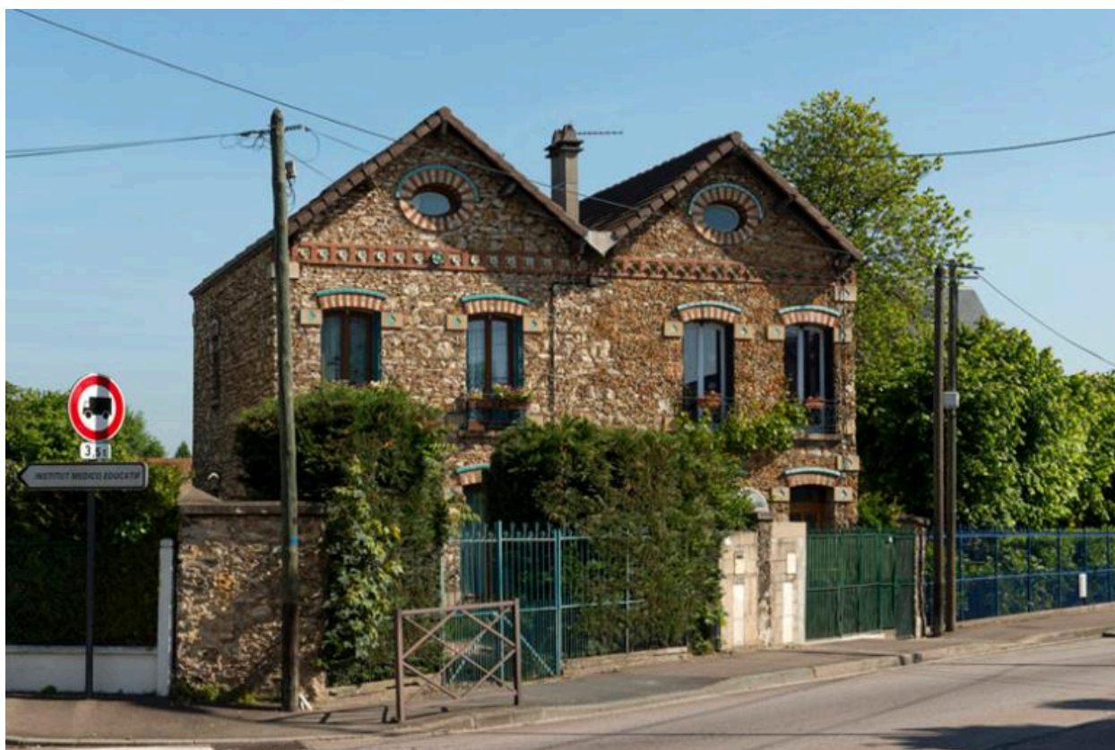
Les Mureaux. Maisons jumelles,32-34, boulevard du Maréchal Foch. Façades principales.
