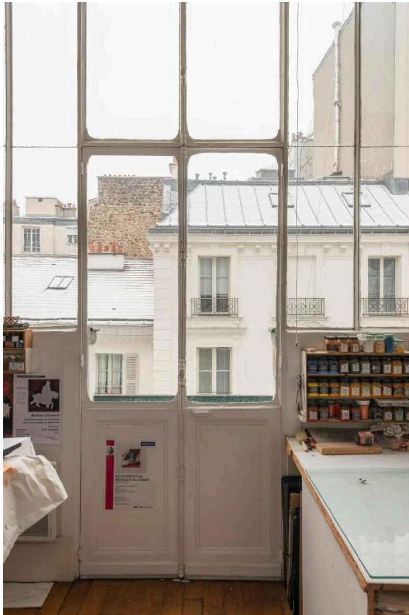
Détail de la verrière en verre soufflé et sa porte menant à un petit balconet (atelier côté rue Hégésippe Moreau)
