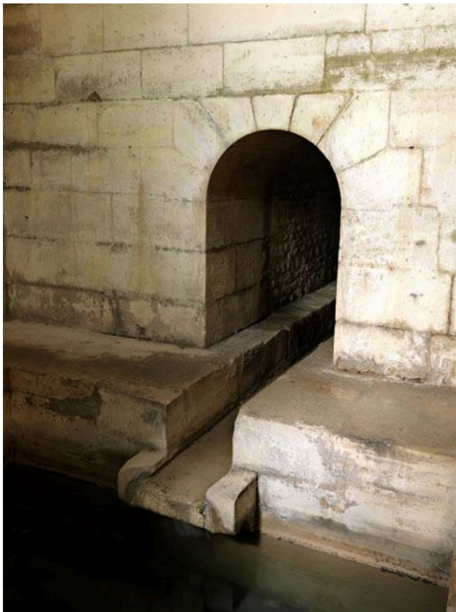
Rungis, Ecoliers (passage des). Vue de la galerie amenant l'eau des sources.
