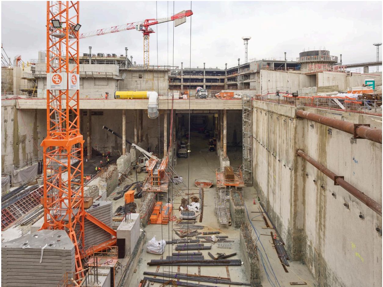
16/12/2020, chantier de construction de la station de métro Aéroport d'Orly (lignes 14 et 18) vu depuis le sud.
