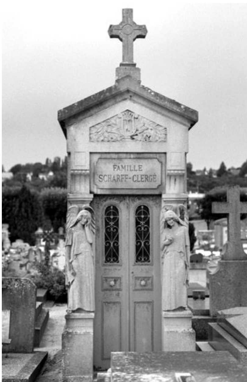
La façade de la chapelle funéraire.
