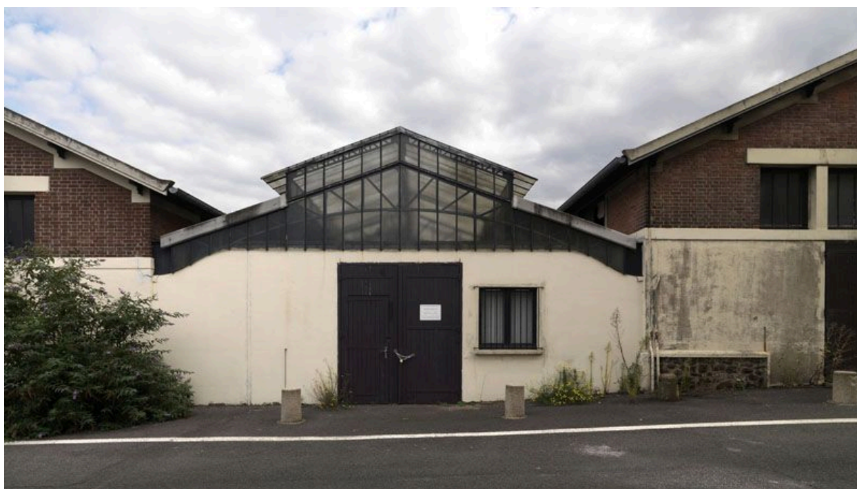
Site Biocitech. Bâtiment éclairé par un lanterneau.
