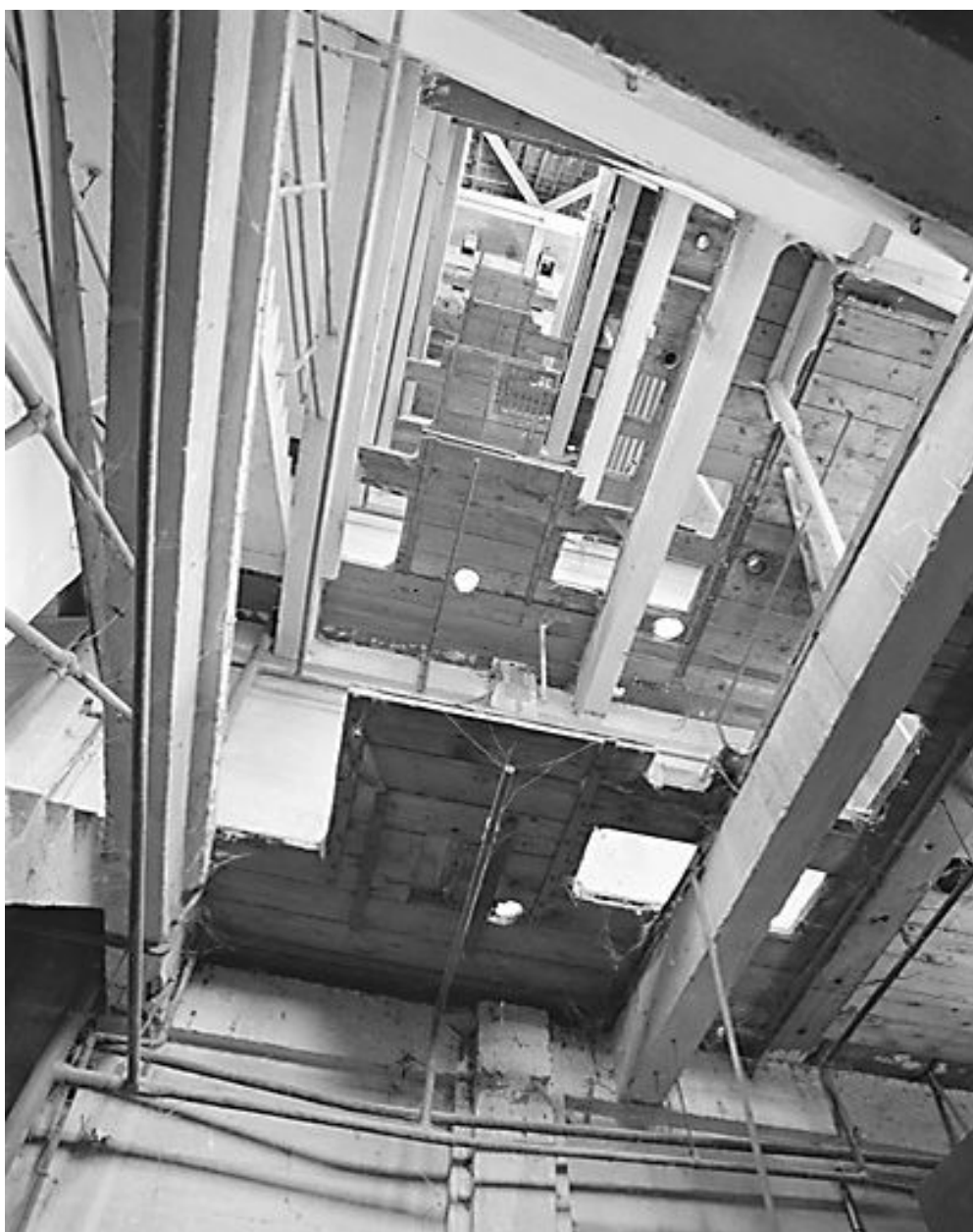
Partie avant-nettoyage. Vue des six niveaux de la minoterie, depuis le rez-de-chaussée.
