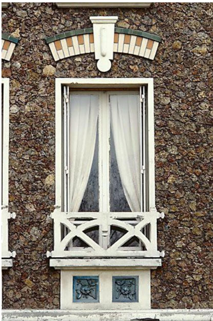
Vue d'une fenêtre avec décor de briques vernissées sur le linteau cintré et de carreaux en grès flammé sur l'allège.
