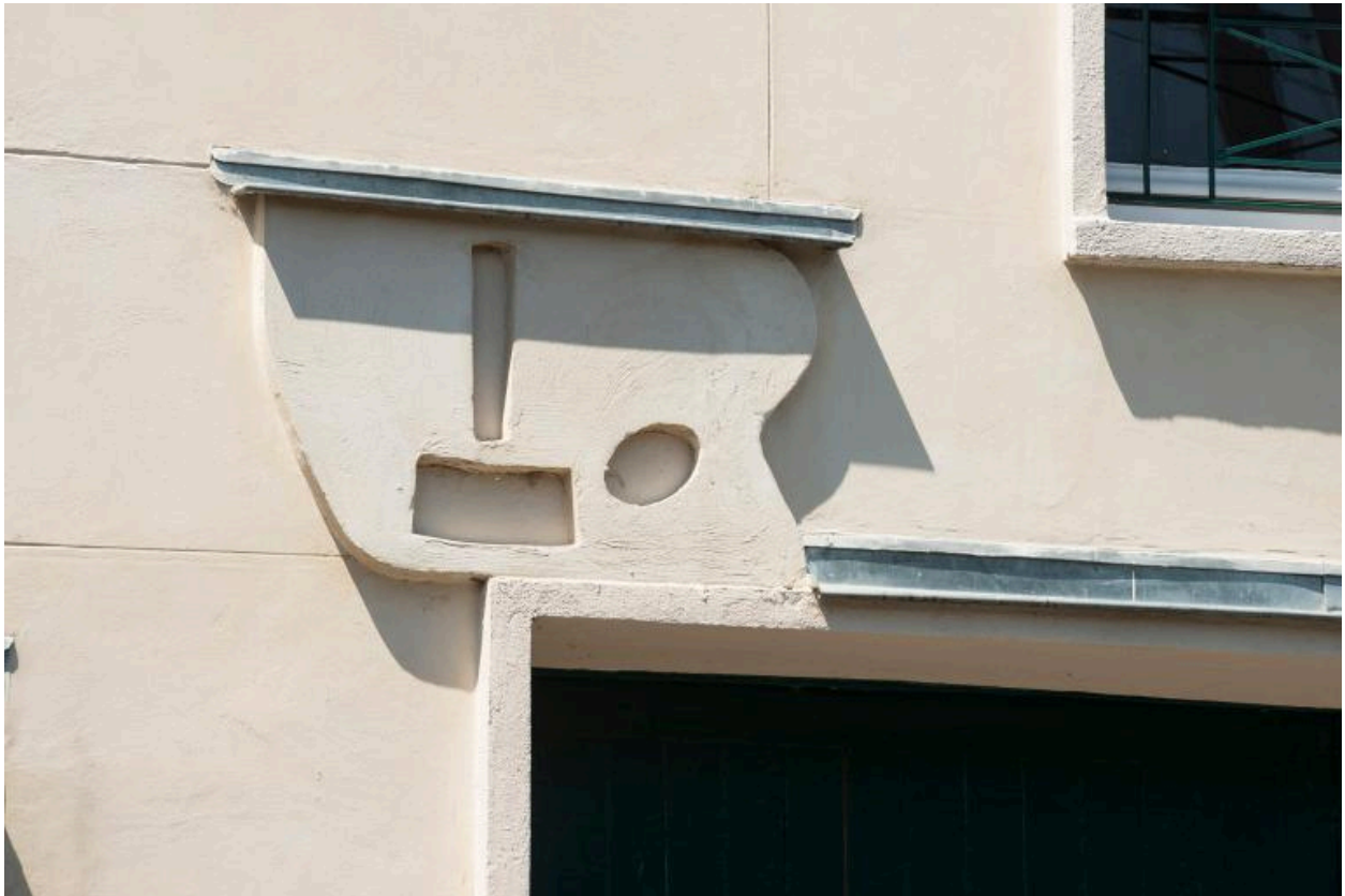
Détail de la façade
