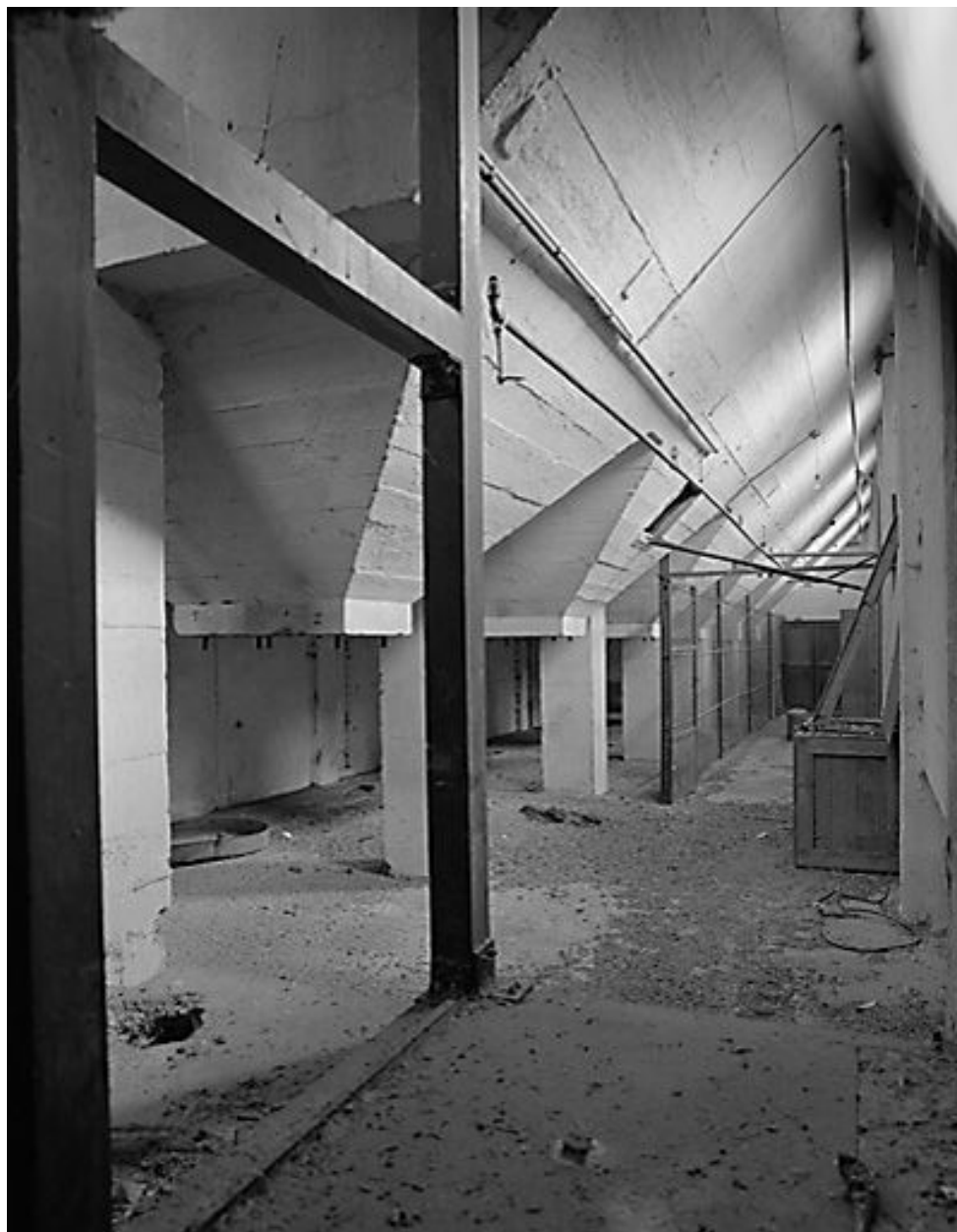
Silos à grains. Trémies en béton armé.
