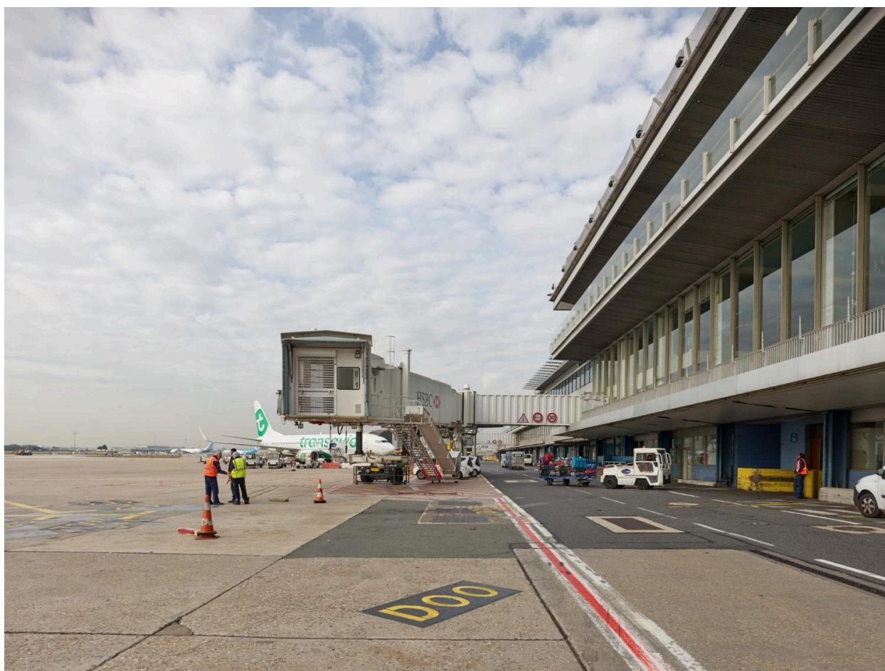
2018, passerelle d'embarquement d'Orly-Sud vu depuis l'est.
