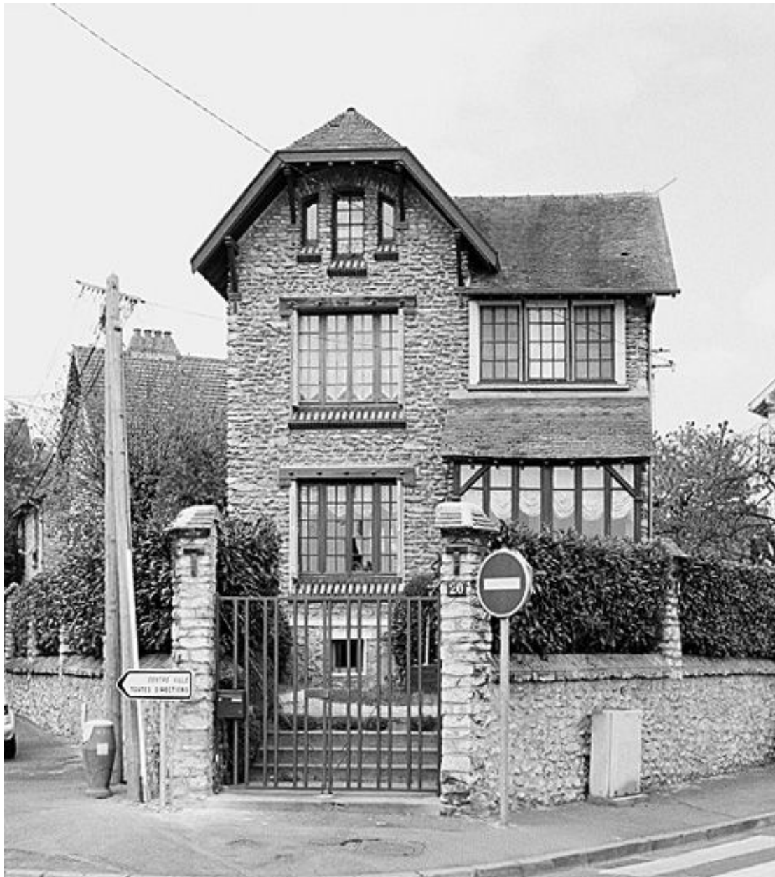
Villa 20, quai du Maréchal-Joffre (à l'angle de la rue Augereau).
