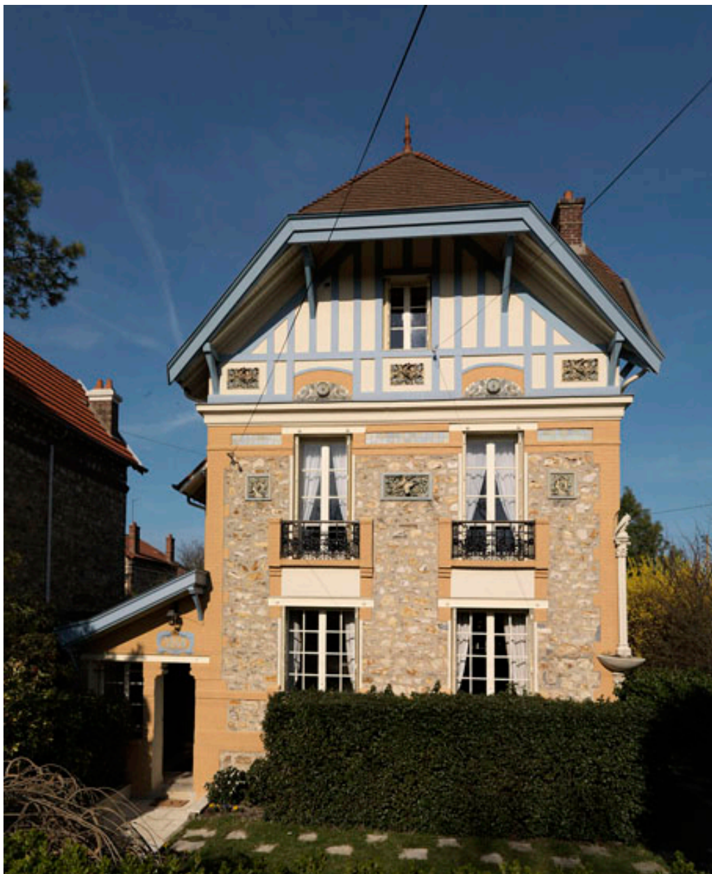
Vue d'ensemble depuis le jardin.
