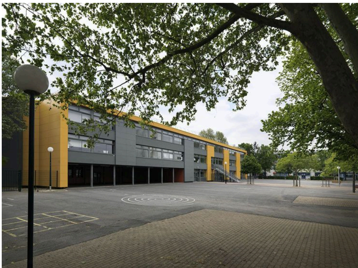
Groupe scolaire Albert Camus, avenue de la République. Vue générale.
