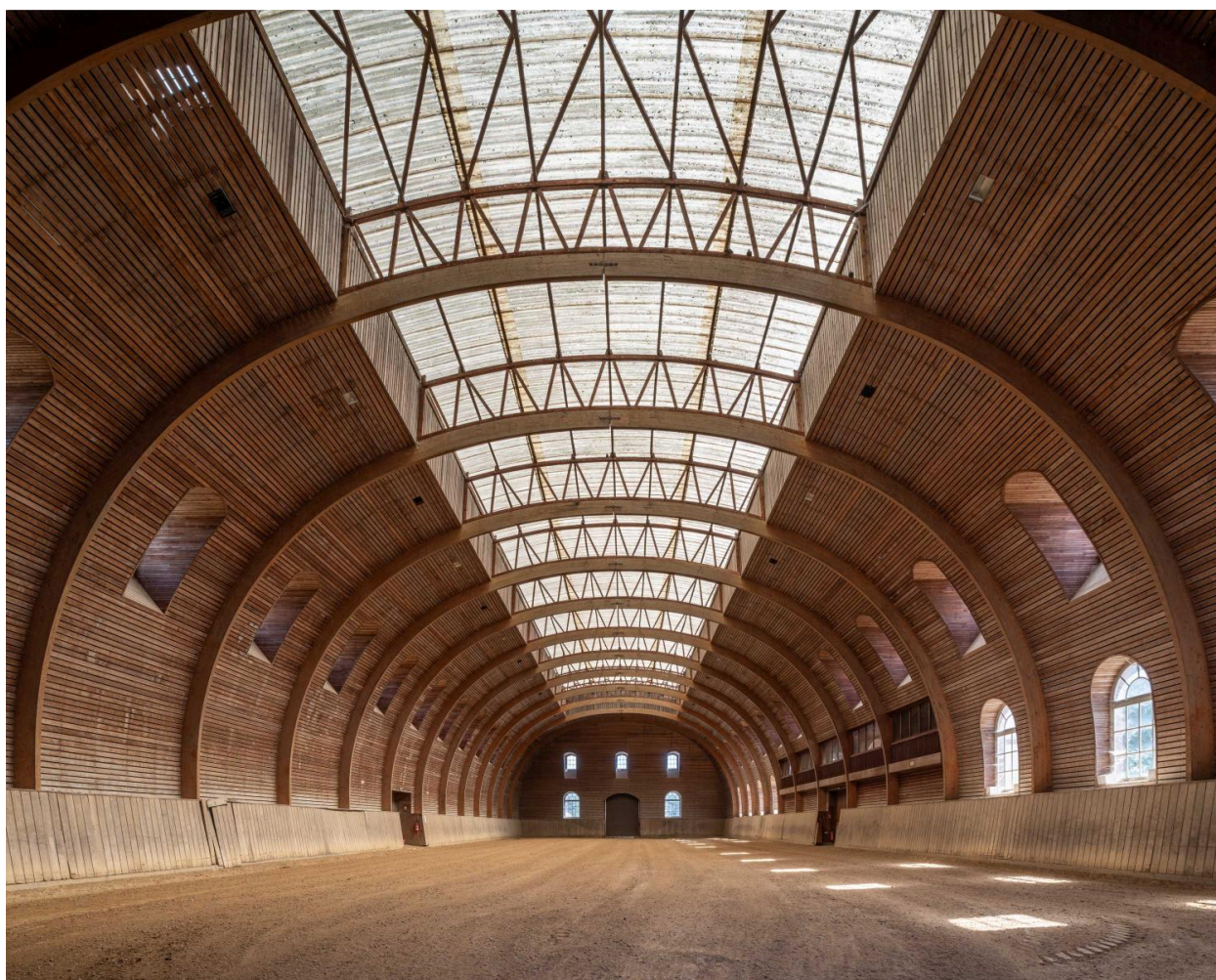
Vue intérieure du manège à chevaux du centre d'entraînement.
