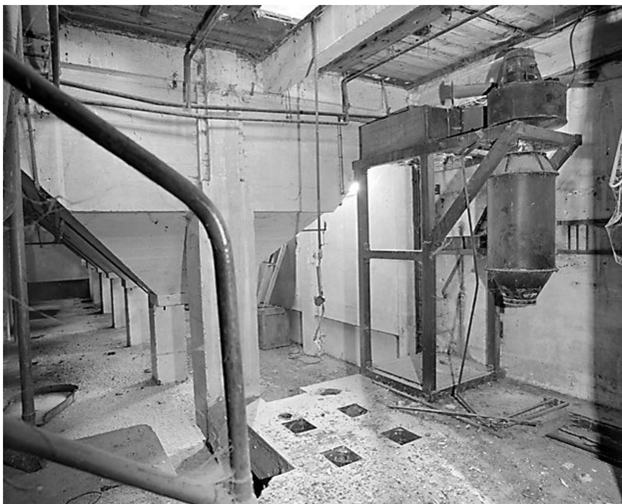
Silos à grains. Trémies en béton armé.
