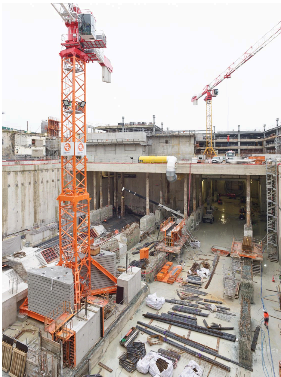
16/12/2020, chantier de construction de la station de métro Aéroport d'Orly (lignes 14 et 18) vu depuis le sud.
