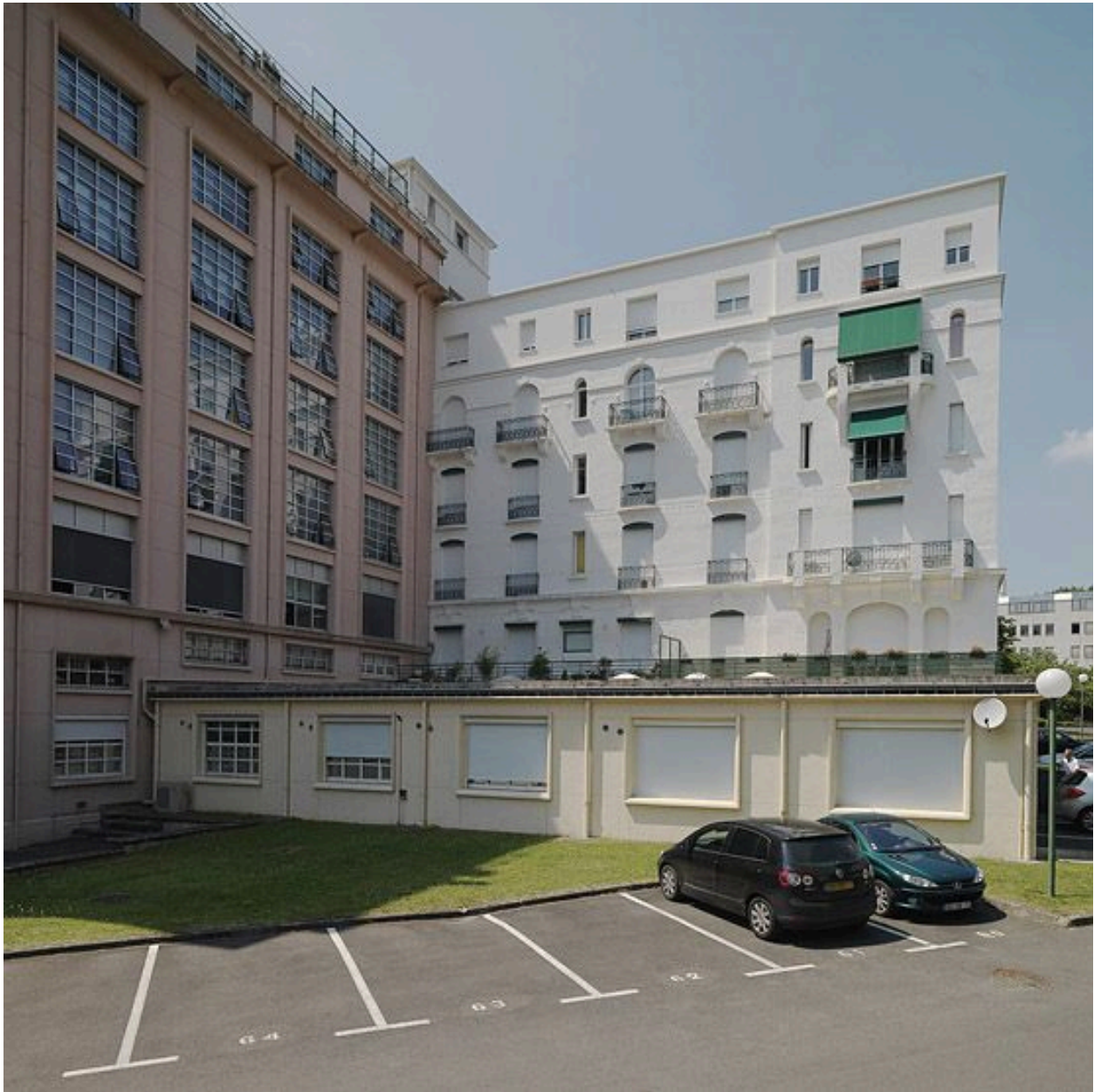
Façade sud de l'hôtel Savoy et façade sud-est de l'extension PIC.
