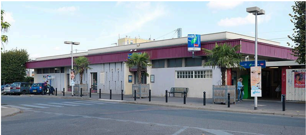
Orly, gare. Elévation antérieure.
