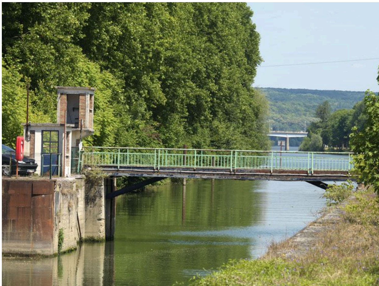
Les Mureaux : ancienne écluse.
