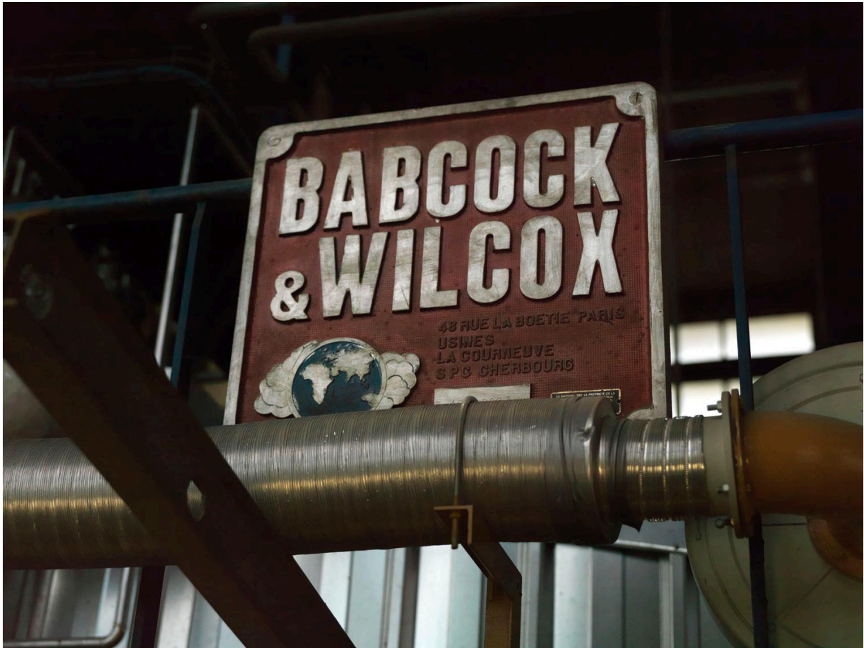
Site Sanofi. Plaque Bacock et Wilcox, bâtiment de la chaufferie.
