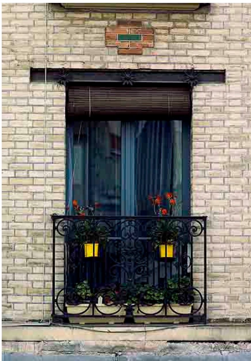
Fonte et ferronnerie ; détail du garde-corps de fonte de l'une des baies d'un immeuble, rue de l'Arrivée.
