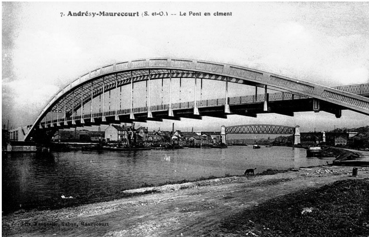
Le pont de Fin d'Oise qui a remplacé le pont suspendu. Carte postale. (Collection particulière).
