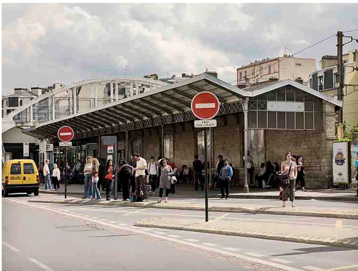
Vue d'ensemble de l'ancienne gare du Refoulons, actuelle gare routière.
