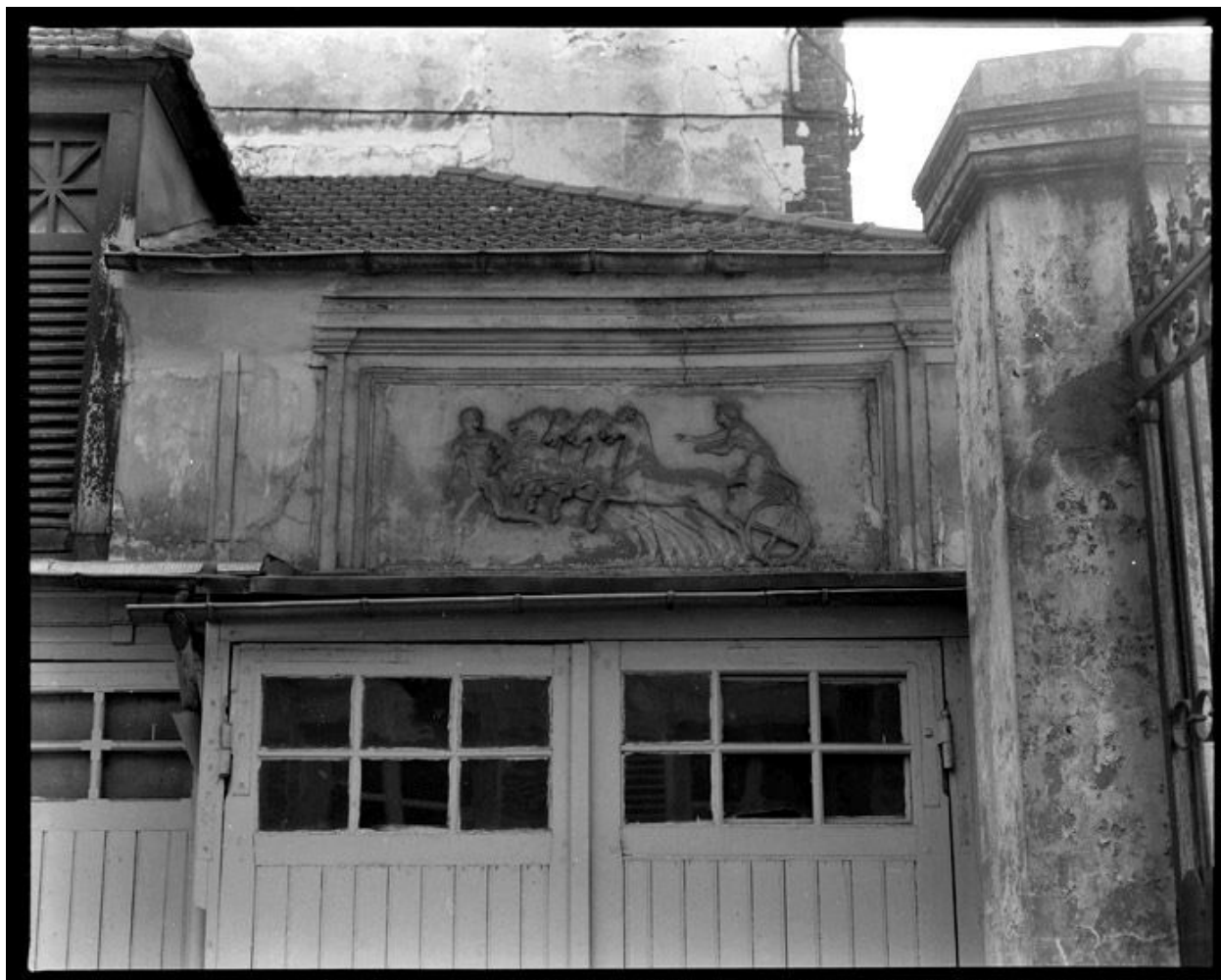
Maison, Gambetta (rue) 2. Les anciennes écuries.
