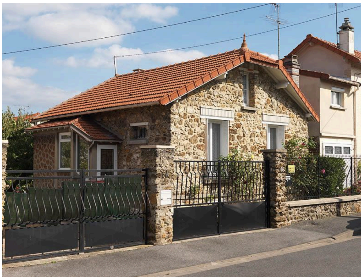
Orly, maison, 16 rue Victor-Hugo. Vue d'ensemble.
