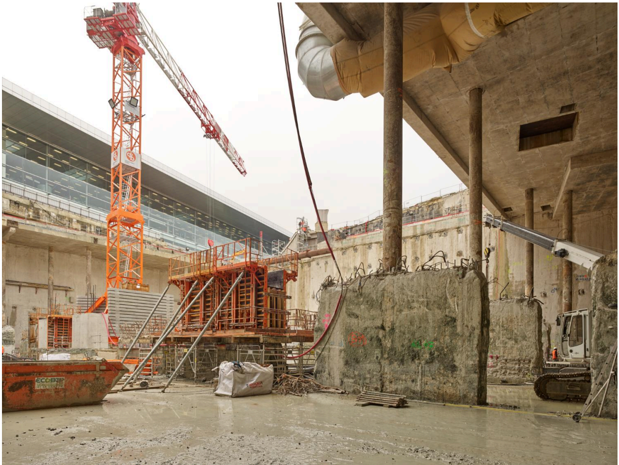
16/12/2020, chantier de construction de la station de métro Aéroport d'Orly (lignes 14 et 18) vu depuis le nord est.
