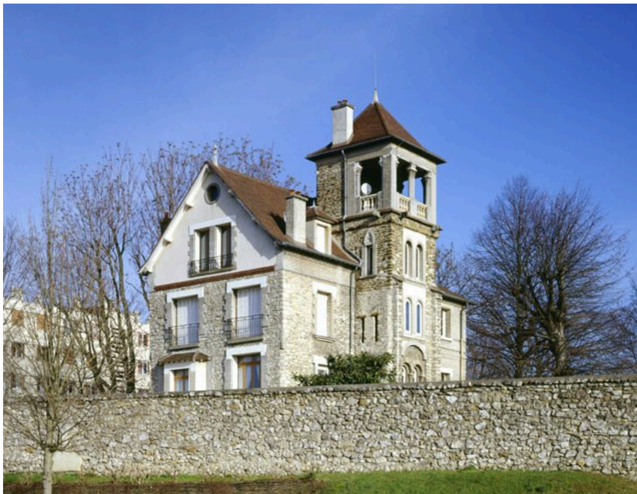
Maison, 13 rue des Hauts-Perreux. Vue d'ensemble de la maison et de son belvédère.
