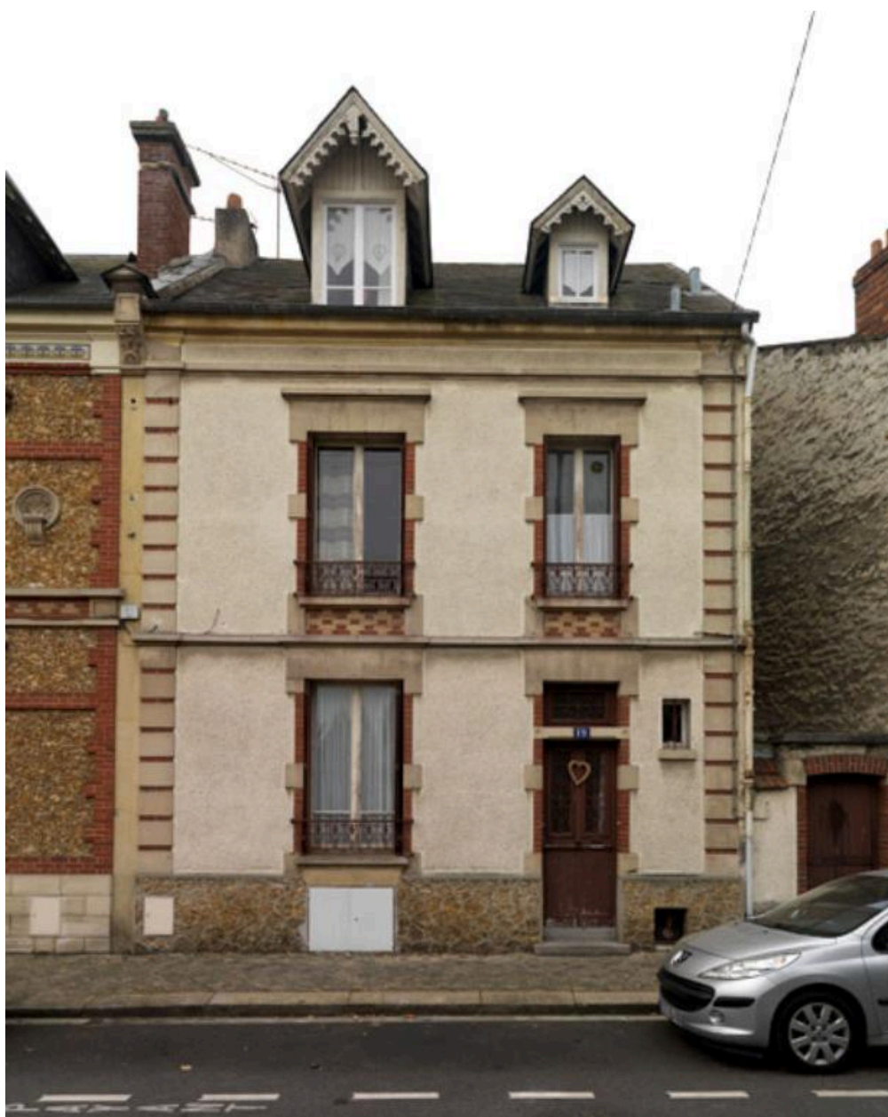
Façade du 19. L'enduit n'est probablement pas d'origine.
