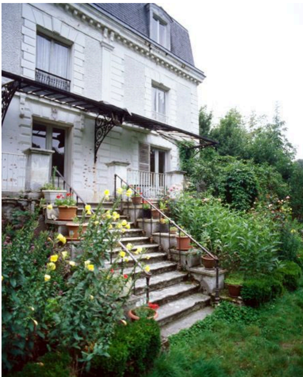
Détail de l'escalier d'accès à la façade postérieure.
