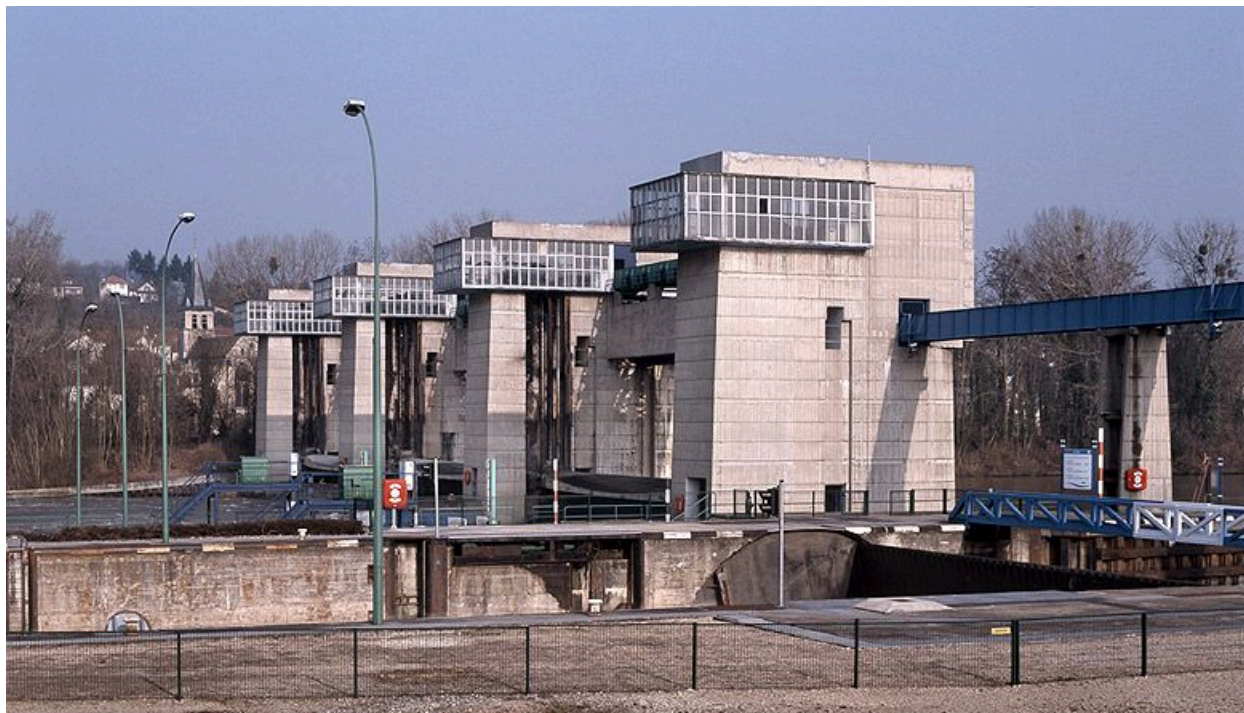
Vue des cabines de manoeuvre des vannes et des écluses.
