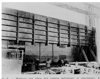
Construction du barrage : montage sur place des vannes inférieure et supérieure. Photographie imprimée. Tiré de : Construction, t. XV, n° 5, mai 1960. (Musée de l'Ile-de-France). Autr. Louis Rémy Sabattier IVR11_20027800581XB
