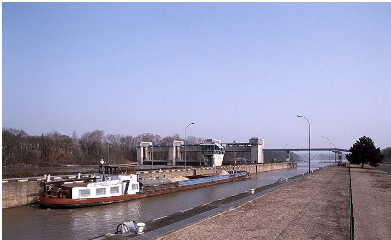
Une péniche en train de francher l'écluse vers l'amont.
