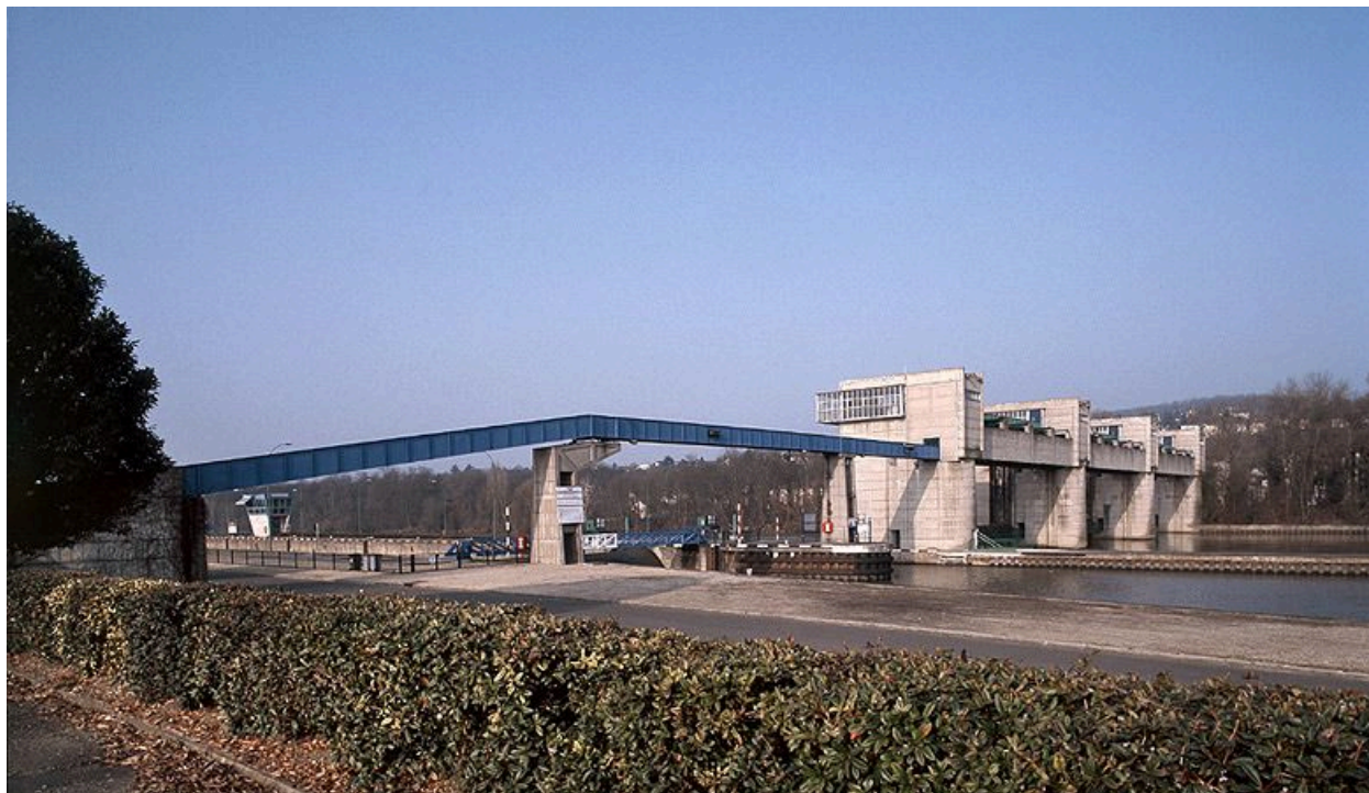
Vue d'ensemble du barrage et des écluses.
