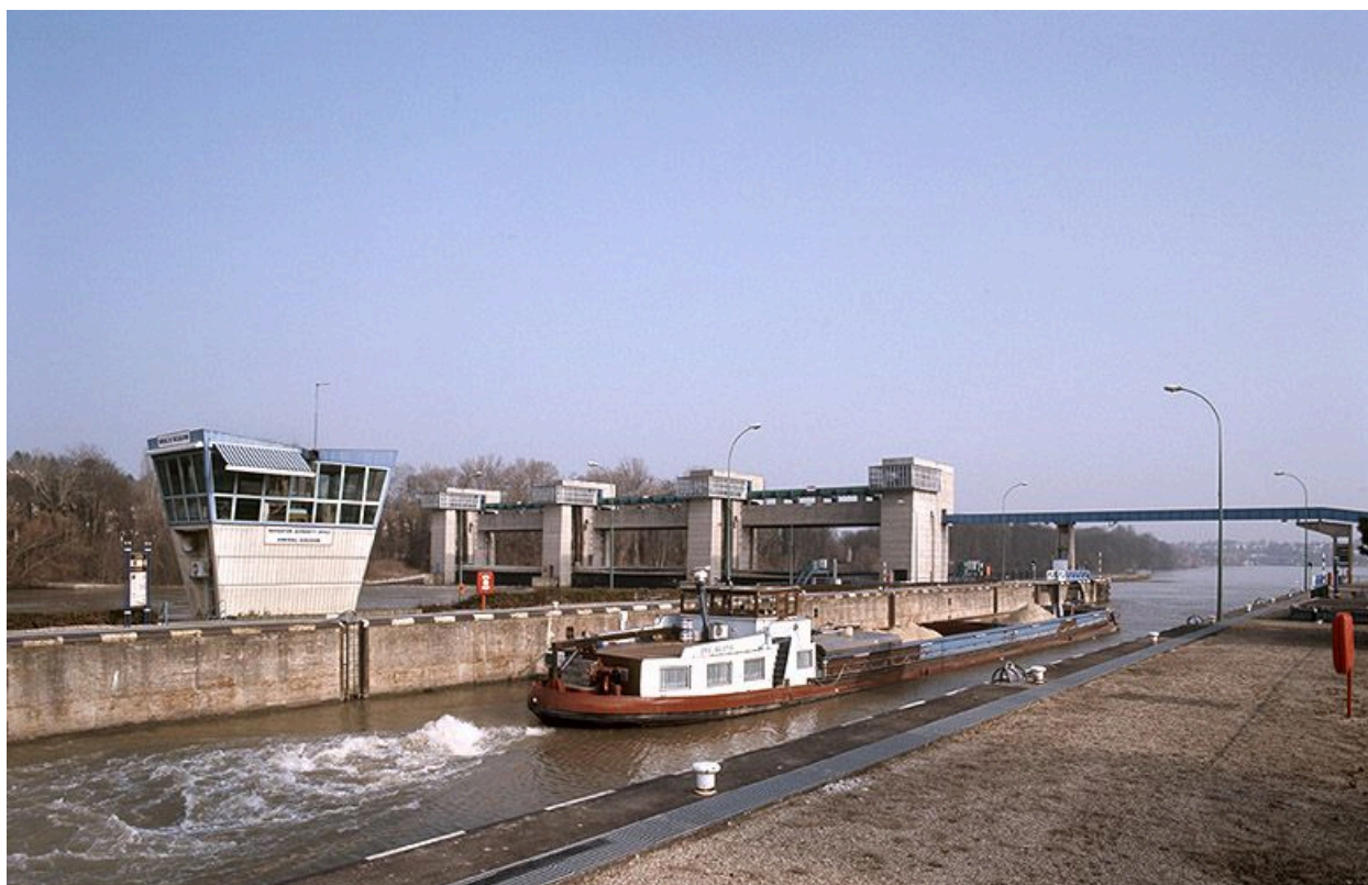
La cabine de contrôle, la péniche et l'écluse.
