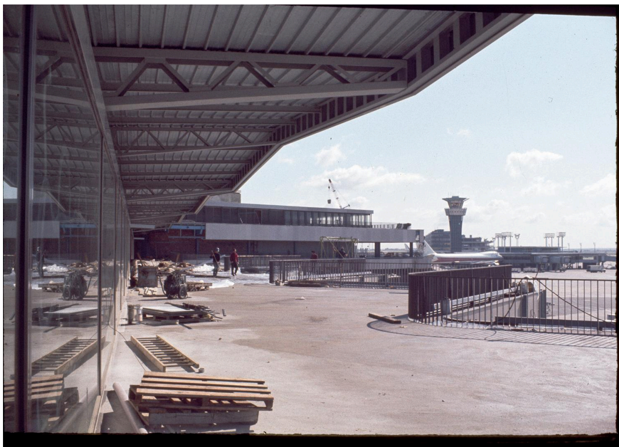
1970, construction d'Orly-Ouest (1968 1971), "coté piste" du terminal prise depuis l'ouest.
