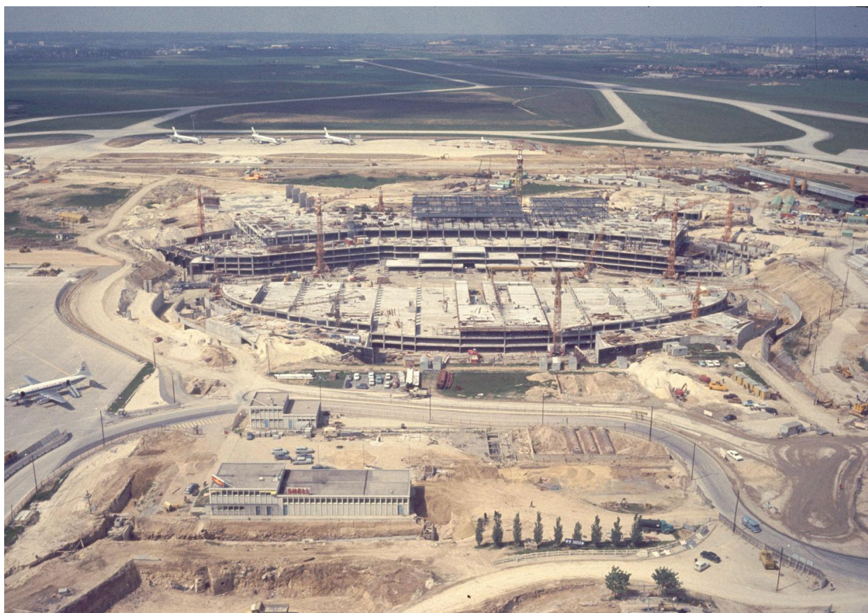
1969, construction d'Orly-Ouest (1968 1971), vue du chantier prise depuis l'est.
