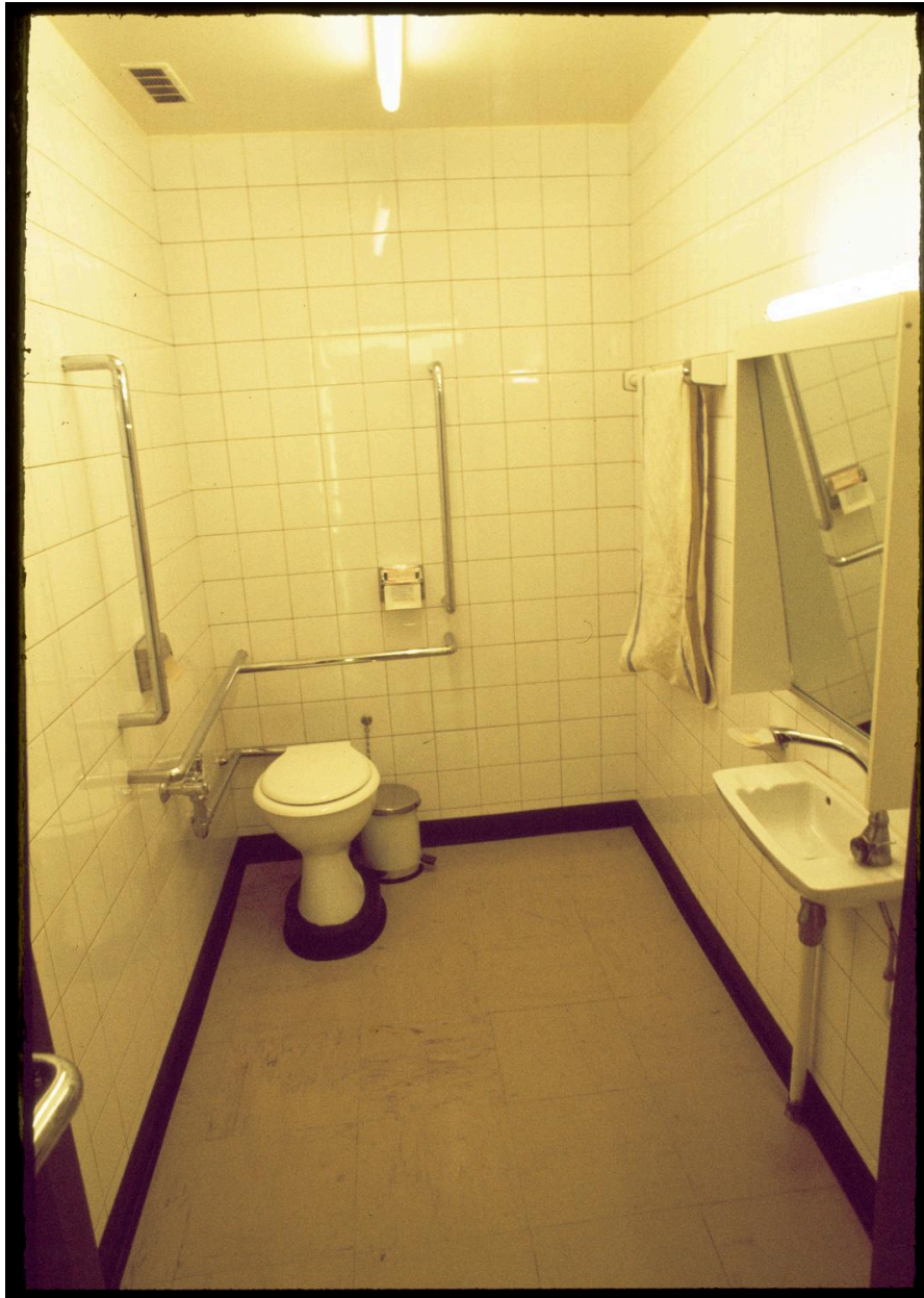
Vers 1970, Orly-Ouest, water-closet.
