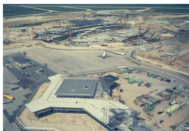
1968, construction d'Orly-Ouest (1968 1971), vue prise depuis le sud est. IVR11_20209400623NUC4A
