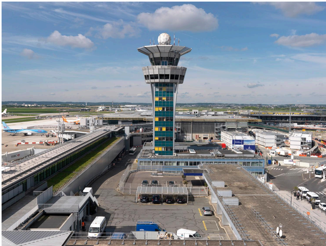
2018, la jetée ouest, le satellite ouest, la tour de contrôle, le chantier de construction d'Orly 3 et Orly-Ouest, vus des terrasses d'Orly-Sud, vue prise depuis l'est.
