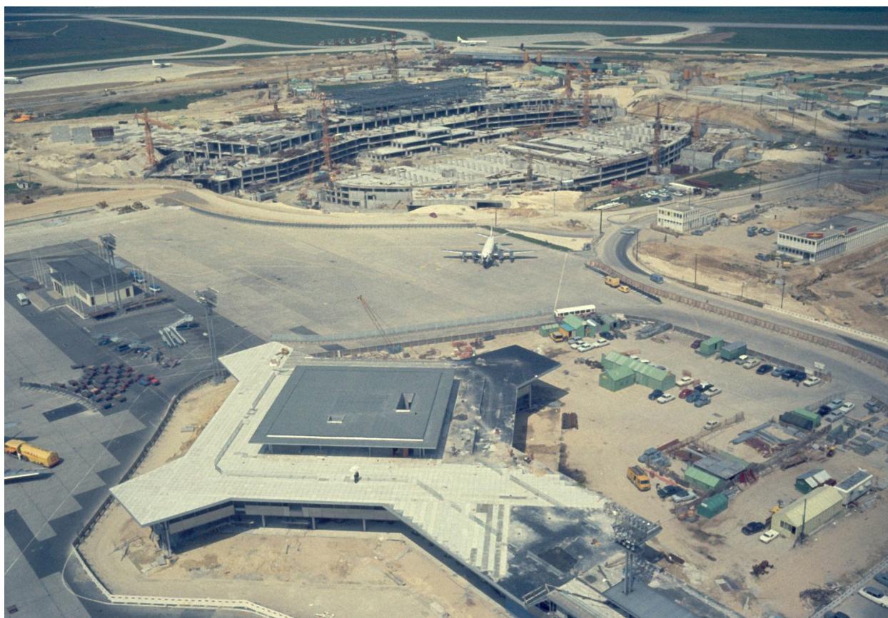
1968, construction d'Orly-Ouest (1968 1971), vue prise depuis le sud est.
