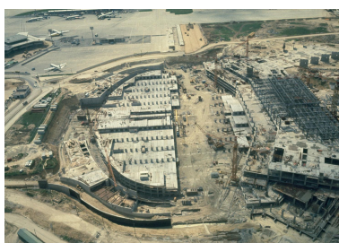
1969, construction d'Orly-Ouest (1968 1971), vue du chantier prise depuis le nord. IVR11_20209400552NUC4A
