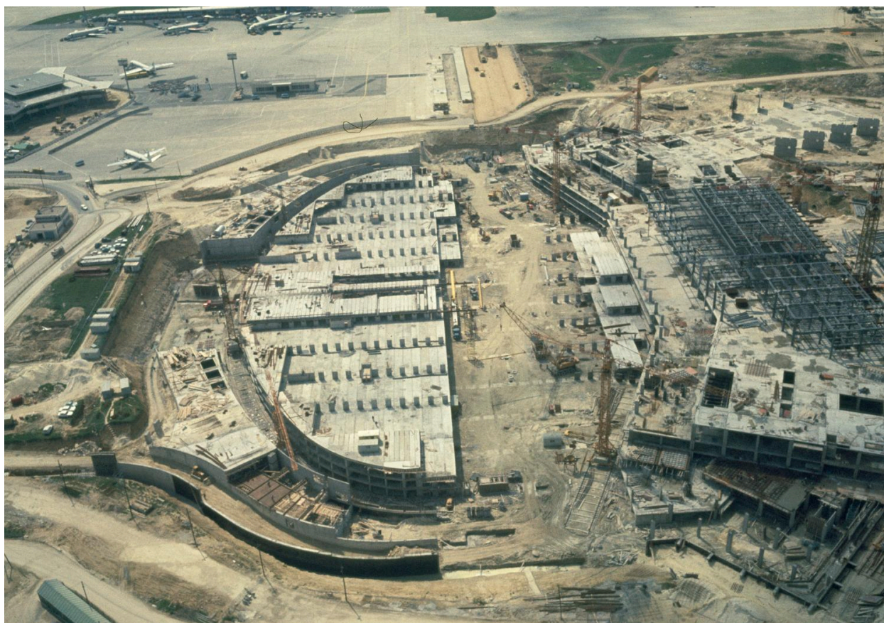
1969, construction d'Orly-Ouest (1968 1971), vue du chantier prise depuis le nord.
