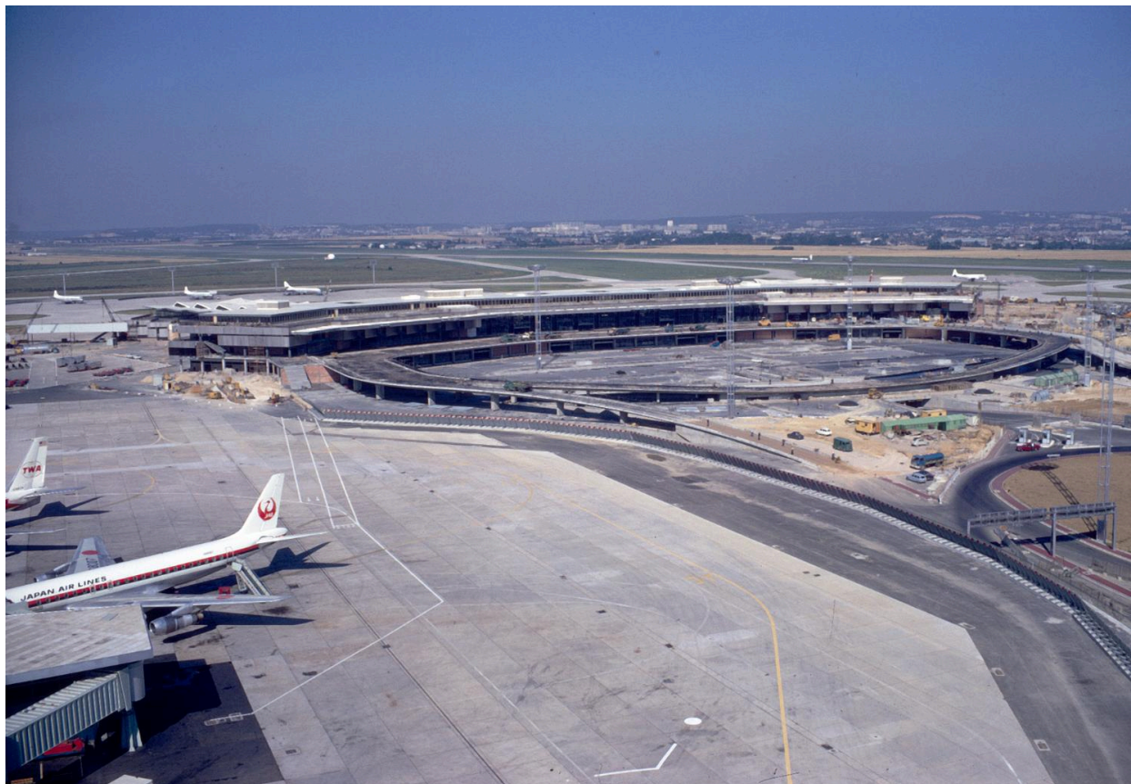
25/11/1970, construction d'Orly-Ouest (1968 1971), vue prise depuis sud est.
