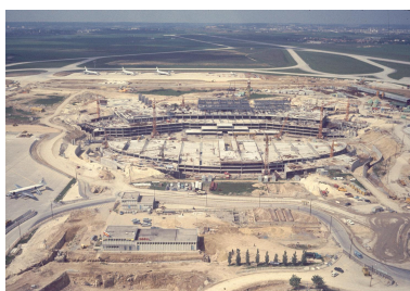
1969, construction d'Orly-Ouest (1968 1971), vue du chantier prise depuis l'est. IVR11_20209400555NUC4A
