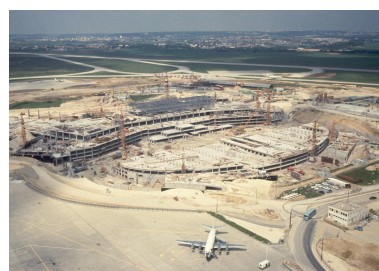
1969, construction d'Orly-Ouest (1968 1971), vue du chantier prise depuis le sud est. IVR11_20209400553NUC4A
