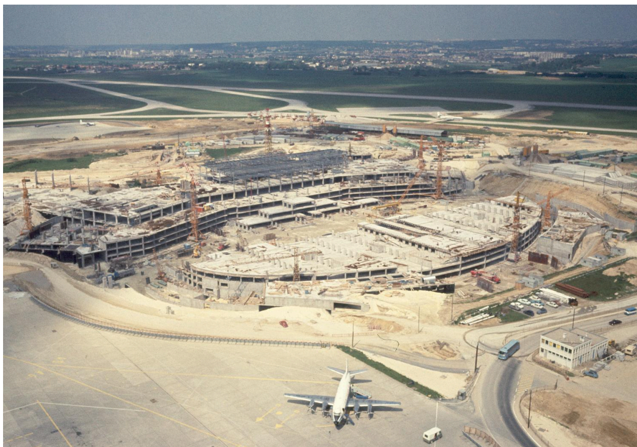
1969, construction d'Orly-Ouest (1968 1971), vue du chantier prise depuis le sud est.
