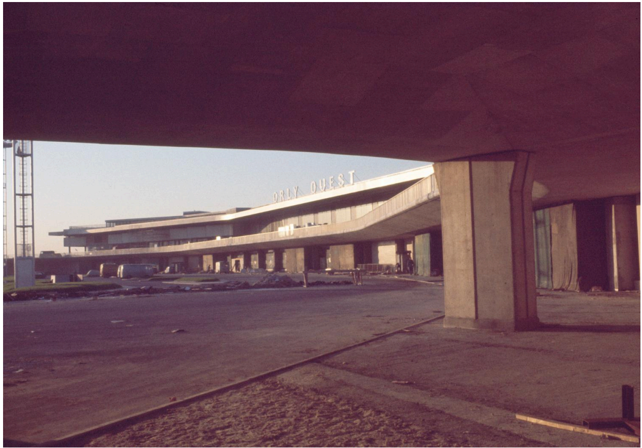
25/11/1970, construction d'Orly-Ouest (1968 1971), la façade "coté ville" du terminal prise depuis nord est.
