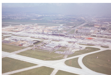
1969, construction d'Orly-Ouest (1968 1971), vue prise depuis le sud. IVR11_20209400766NUC4A
