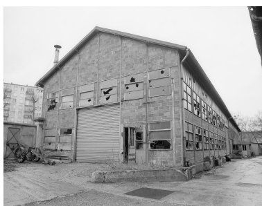
Le bâtiment de l'atelier de mécanique vu de la cour. Photographie. (AD Seine-Saint-Denis. A NB 92) IVR11_20029300116NUC
