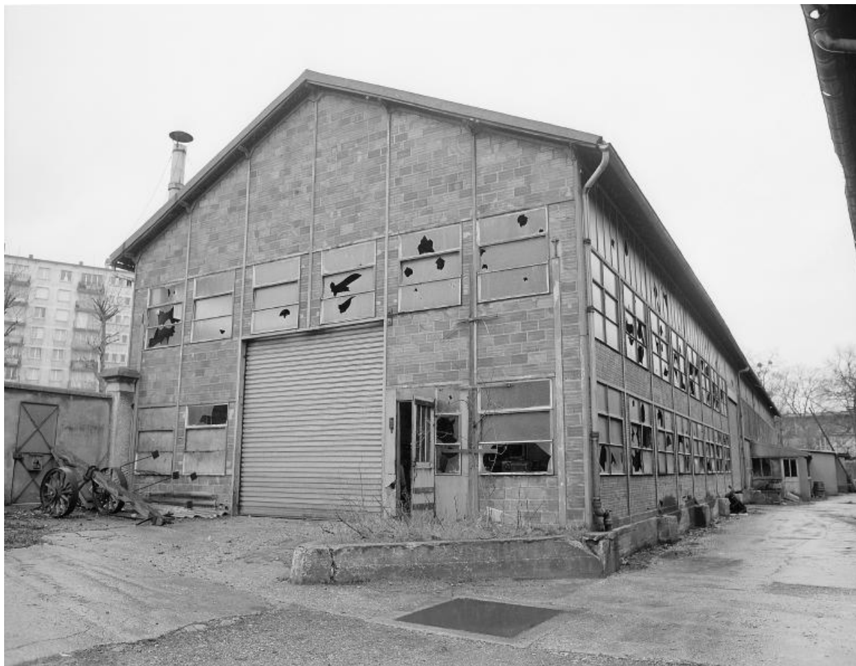
Le bâtiment de l'atelier de mécanique vu de la cour. Photographie. (AD Seine-Saint-Denis. A NB 92)
