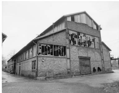
Bâtiment de forgeage. Photographie. (AD Seine-Saint-Denis. A NB 92) IVR11_20029300103NUC
