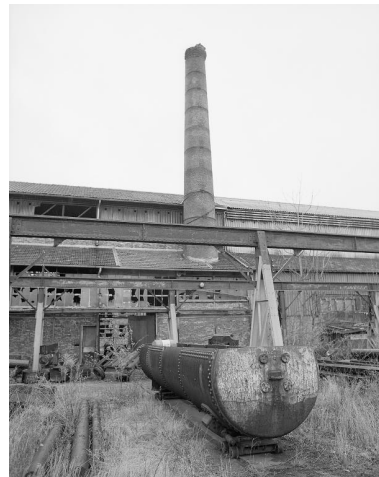
Chaudière et cheminée. Photographie. (AD Seine-Saint-Denis. A NB 92) IVR11_20029300105NUC
