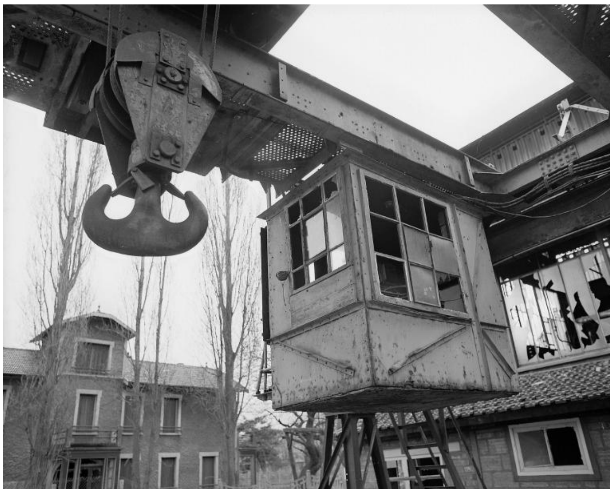
La cabine du pont roulant. Photographie. (AD Seine-Saint-Denis. A NB 92)
