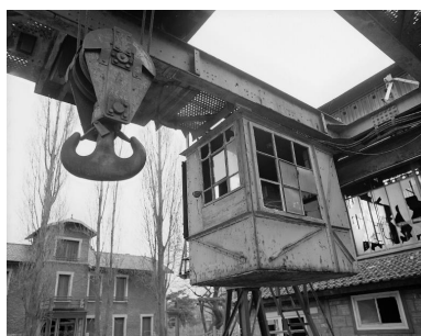
La cabine du pont roulant. Photographie. (AD Seine-Saint-Denis. A NB 92) IVR11_20029300115NUC
