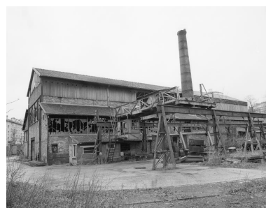
Le bâtiment de forgeage et le pont roulant. Photographie. (AD Seine-Saint-Denis. A NB 92) IVR11_20029300117NUC
