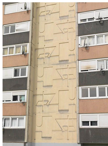
Une tour de la Pierre-Collinet. Détail de la mise en oeuvre du béton moulé sur la façade arrière. Phot. Stéphane Asseline IVR11_20097701057NUC4A
