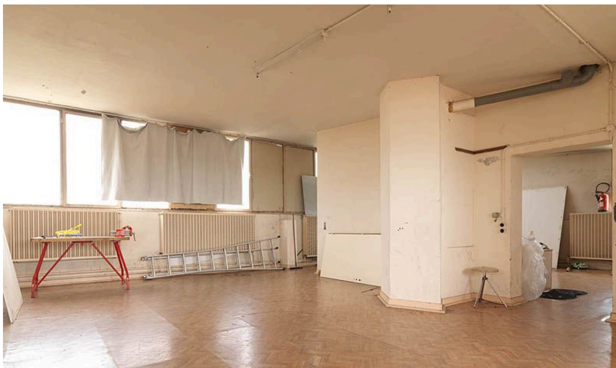
L'immeuble prototype. Vue intérieure des anciens séchoirs.
