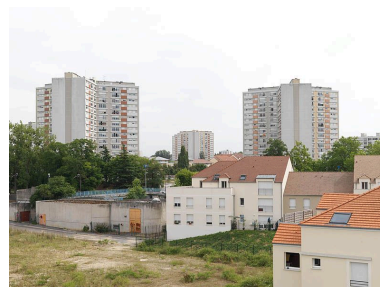
Chaufferie d'appoint de la Pierre-Collinet destinée au chauffage urbain. Vue en arrière plan des tours de Beauval. Phot. Stéphane Asseline IVR11_20097701063NUC4A
