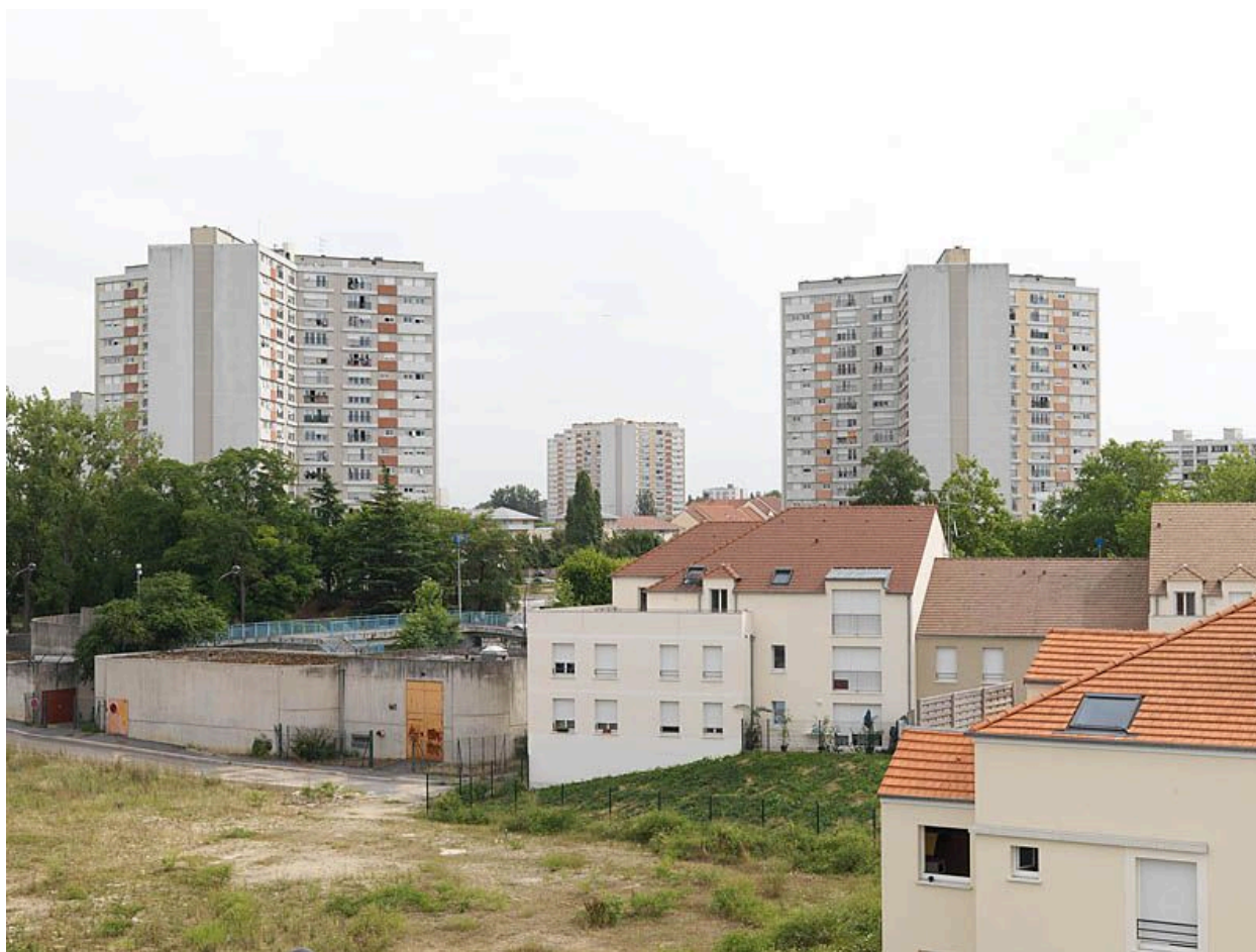
Chaufferie d'appoint de la Pierre-Collinet destinée au chauffage urbain. Vue en arrière plan des tours de Beauval.
