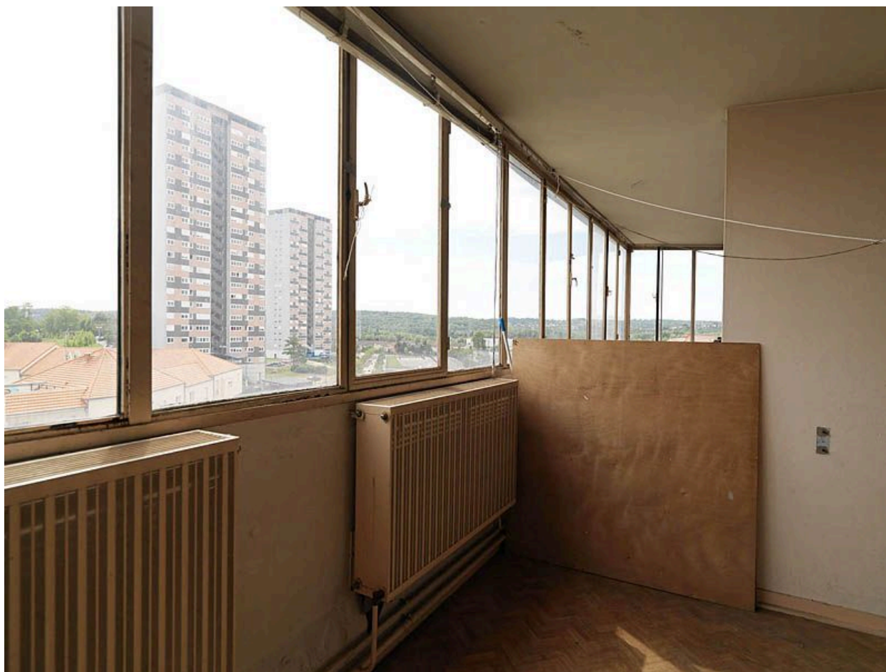
L'immeuble prototype. Vue intérieure des anciens séchoirs.
