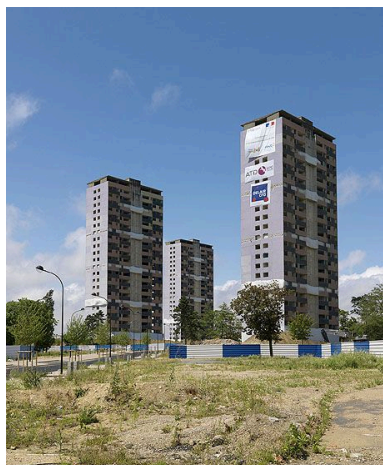
Vue des trois dernières tours de la Pierre Collinet le 22 juin 2011, juste avant leur destruction (25-26 juin). Phot. Jean-Bernard Vialles IVR11_20117700993NUC4A
