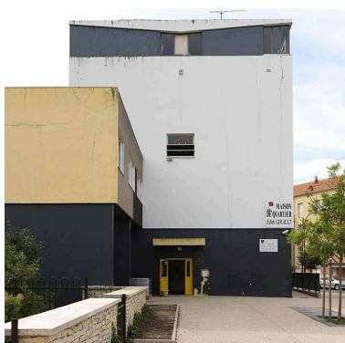
L'immeuble prototype. Aujourd'hui résidence sociale. Phot. Stéphane Asseline IVR11_20097701068NUC4A
