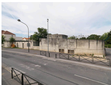
Chaufferie d'appoint de la Pierre- Collinet destinée au chauffage urbain. Phot. Stéphane Asseline IVR11_20097701062NUC4A
