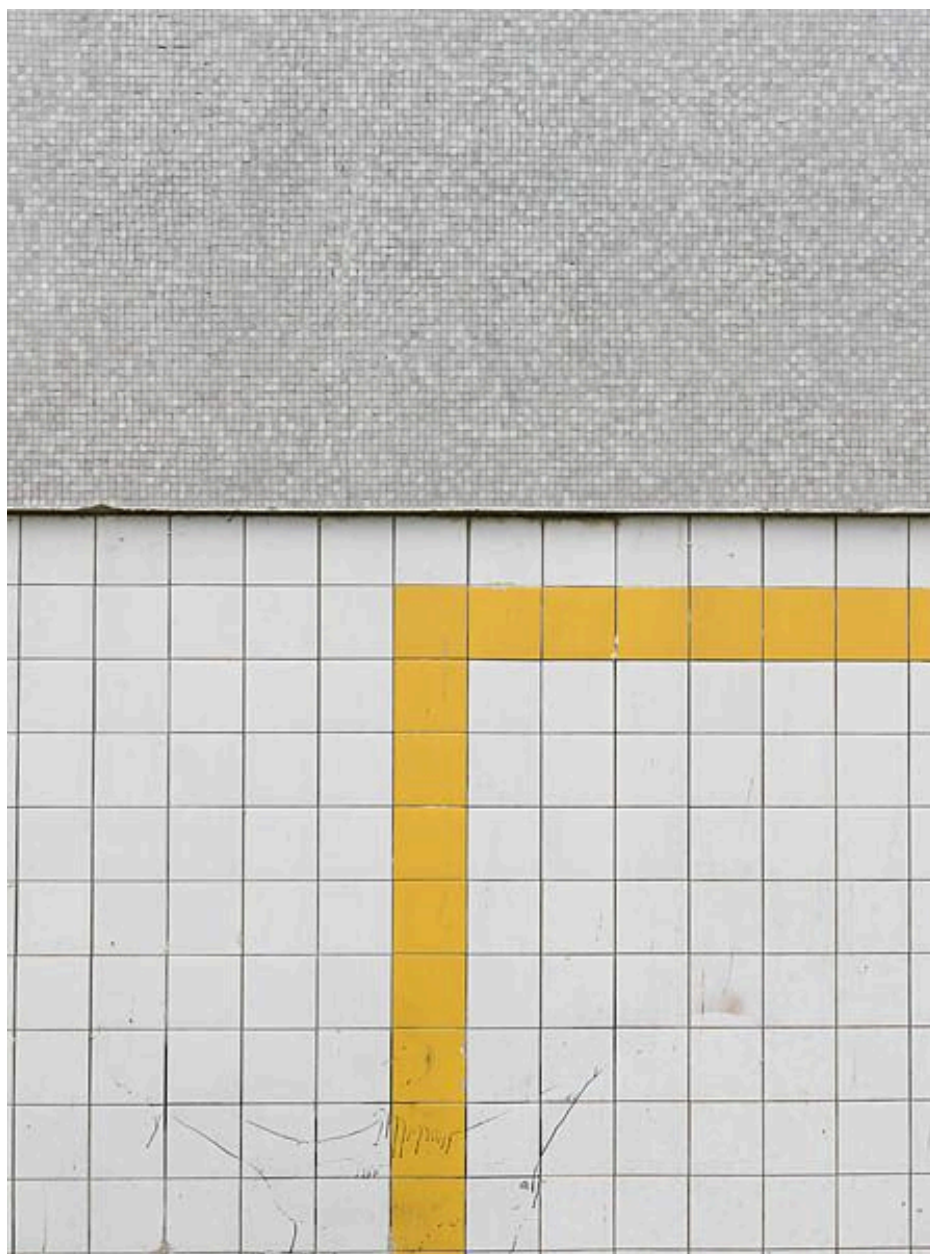
Une tour de la Pierre-Collinet. Façade latérale. Détail de la mise en œuvre des carrelages 20*20 et des pâtes de verres 2*2.
