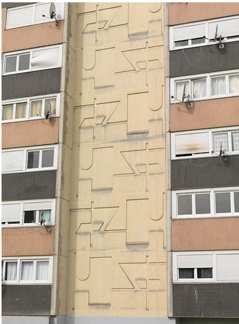
Une tour de la Pierre-Collinet. Détail de la mise en oeuvre du béton moulé sur la façade arrière.
