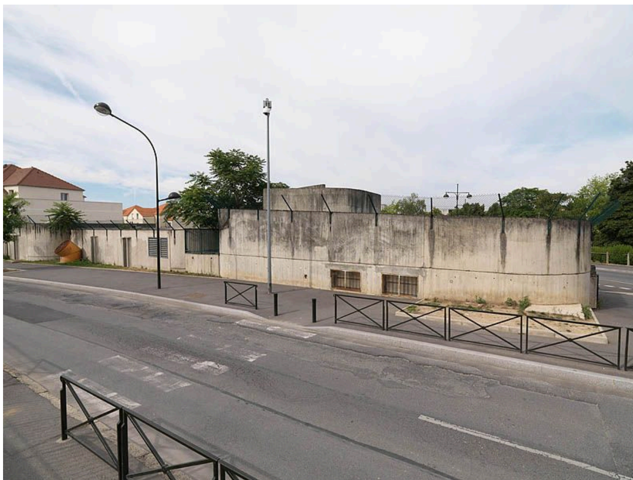
Chaufferie d'appoint de la Pierre-Collinet destinée au chauffage urbain.
