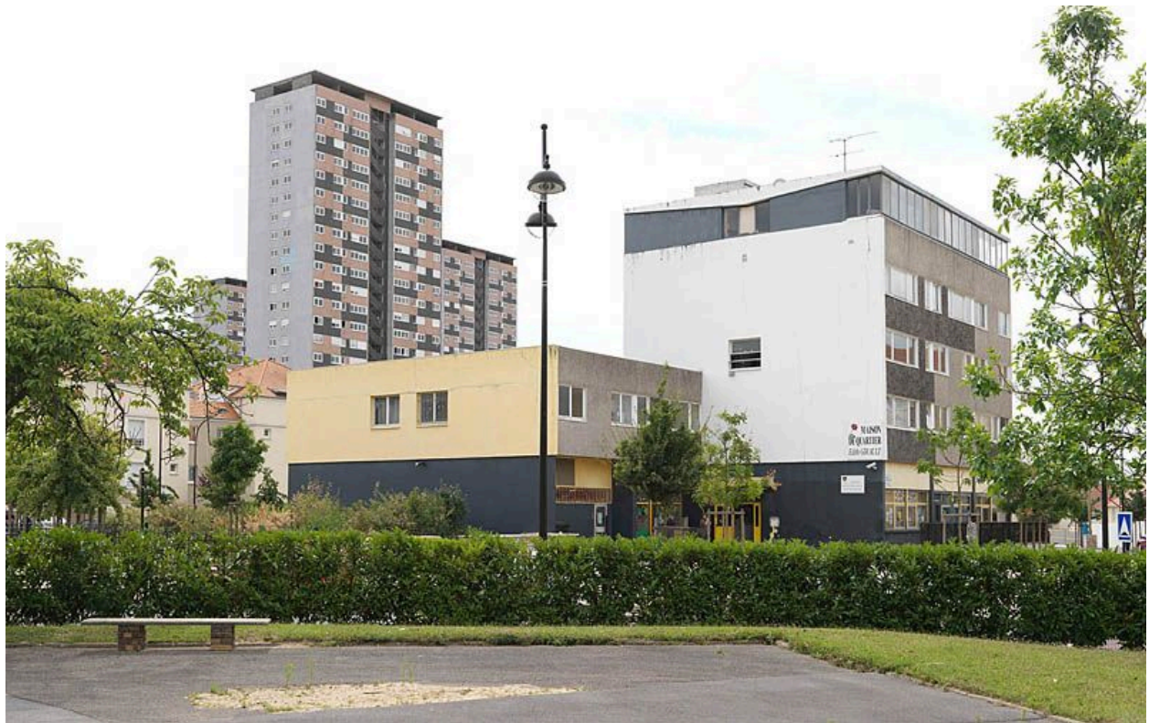
L'immeuble prototype (actuellement résidence sociale) et les tours de la Pierre-Collinet en arrière-plan.
