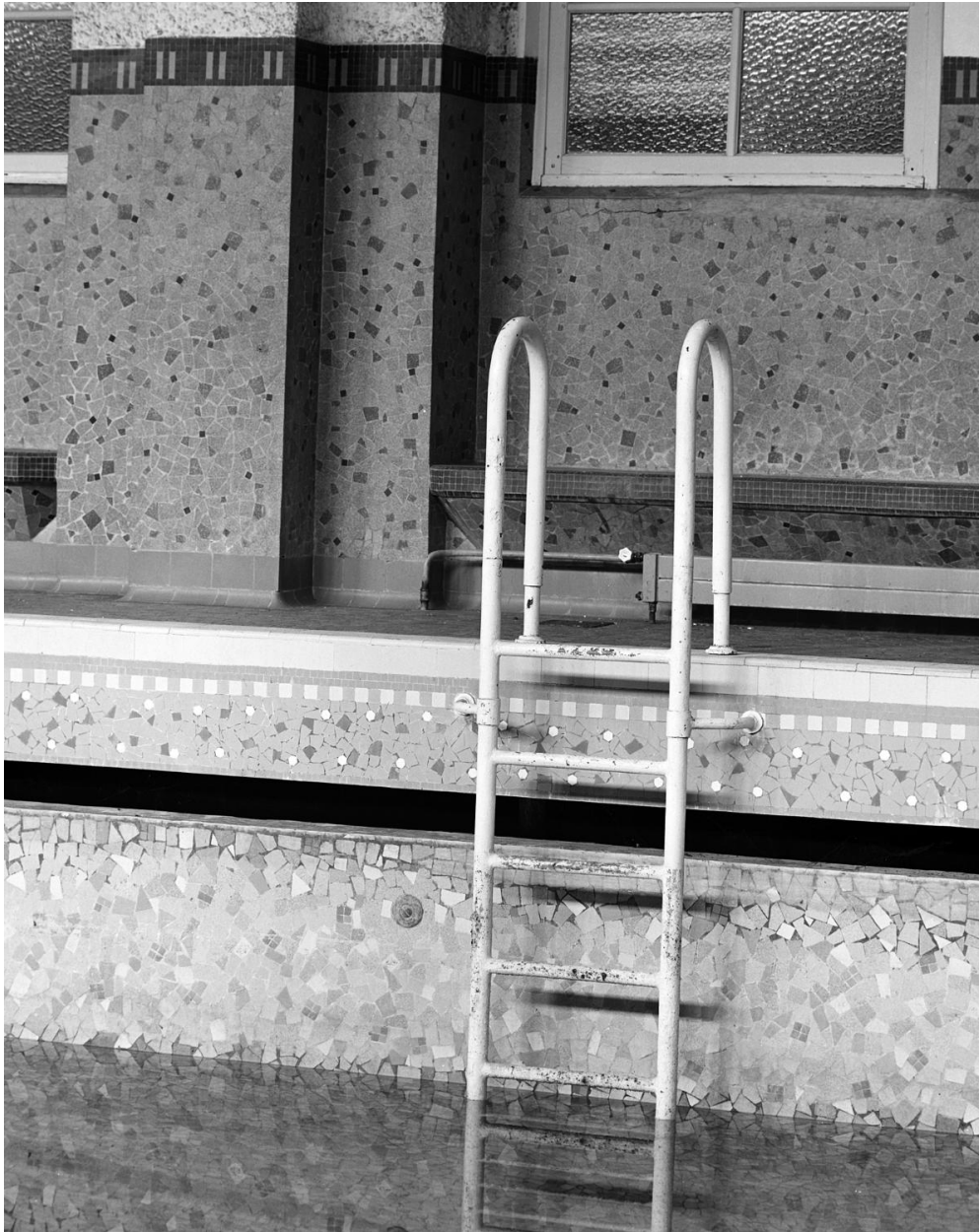
Bâtiment de la piscine/gymnase : détail de revêtement du mur intérieur du hall du bassin.. groupe scolaire - collège Henri-Sellier, puis groupe scolaire - collège de la Cité Jardin
