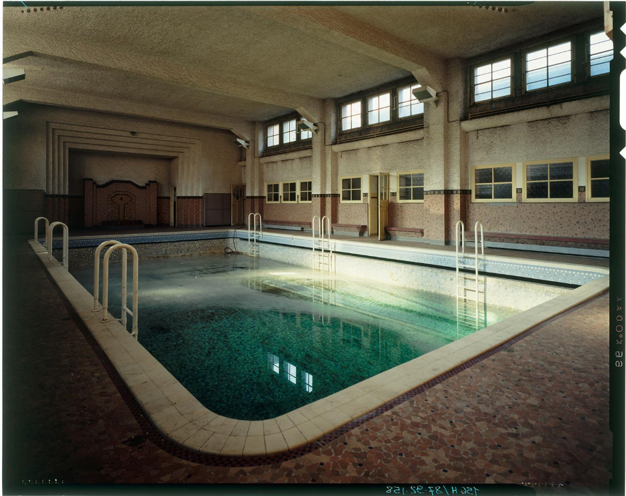
La piscine. Vue intérieure depuis l'entrée.. groupe scolaire de la cité jardin, actuellement Henri Sellier
