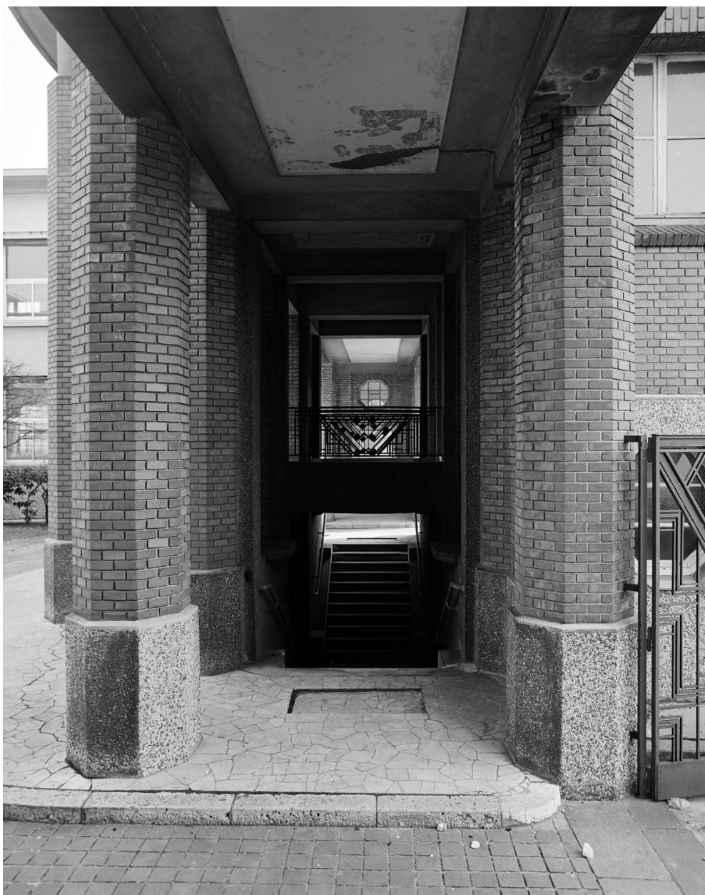
Bâtiment de la piscine : vue sous le porche d'accès (côté gauche).. groupe scolaire - collège Henri-Sellier, puis groupe scolaire - collège de la Cité Jardin
