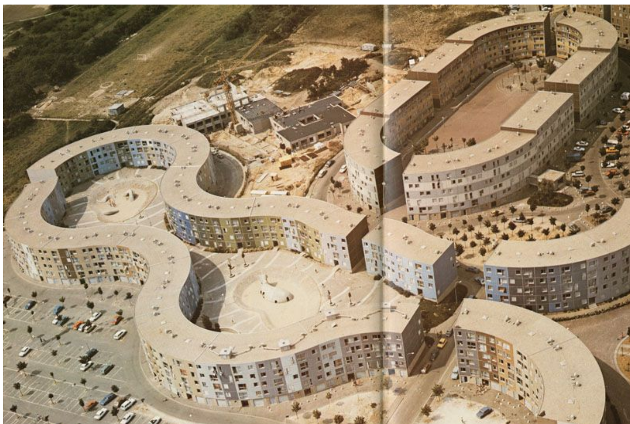
La Noé. Vue aérienne de la place du Bestiaire, aujourd'hui détruite, et de la place de l'Hippodrome, dont toute la moitié ouest est également détruite. Photographie, circa 1978. Tiré de : Chanteloup-les-Vignes : quartier la Noé, architecte Émile Aillaud / Emile Aillaud, Fabio Rieti, Gilles Aillaud, Paris : Fayard, 1978.
