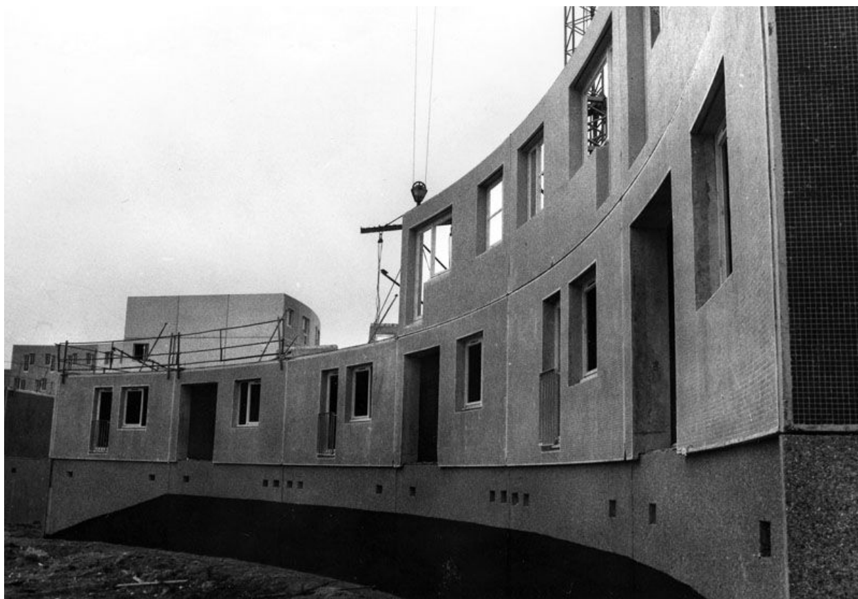
La Noé. Photographie du chantier prise le 17 avril 1973, détail de la mise en place d'un élément de façade préfabriqué (les panneaux comprennent les huisseries et le revêtement de céramique, placé en fond de moule au moment du coulage du béton). (Mairie de Chanteloup-les-Vignes).
