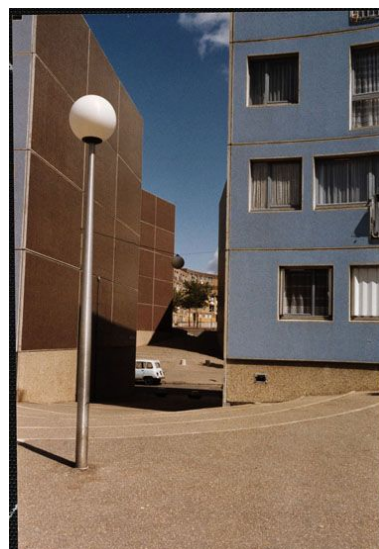
La Noé. Vue du passage entre la place du Bestiaire et au fond celle de l'Hippodrome. Photographie, vers 1978. (Cité de l'architecture et du patrimoine, Archives d'architecture du XXe siècle).
