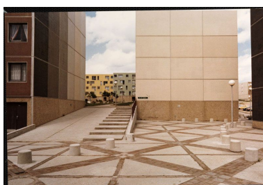
La Noé. Vue du passage entre la place des Arcades et la cour Verte. Photographie, vers 1978. (Cité de l'architecture et du patrimoine, Archives d'architecture du XXe siècle). Phot. Laurent Kruszyk, Autr. Louis Rémy Sabattier IVR11_20087800152NUC4A
