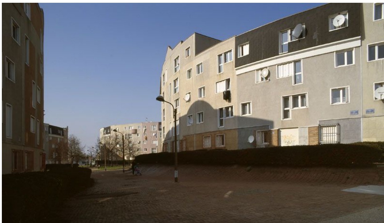
La Noé. Vue d'ensemble actuelle de la place des Quatre-Vents. Les façades ont été totalement transformées par l'isolation extérieure. Les fenêtres ont été changées.
