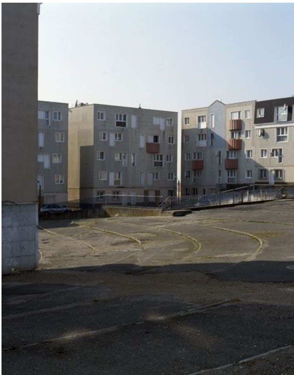
La Noé. Autre vue actuelle de la place de l'Eté-Vert. Les degrés formant le sol n'ont pas été entretenus correctement.
