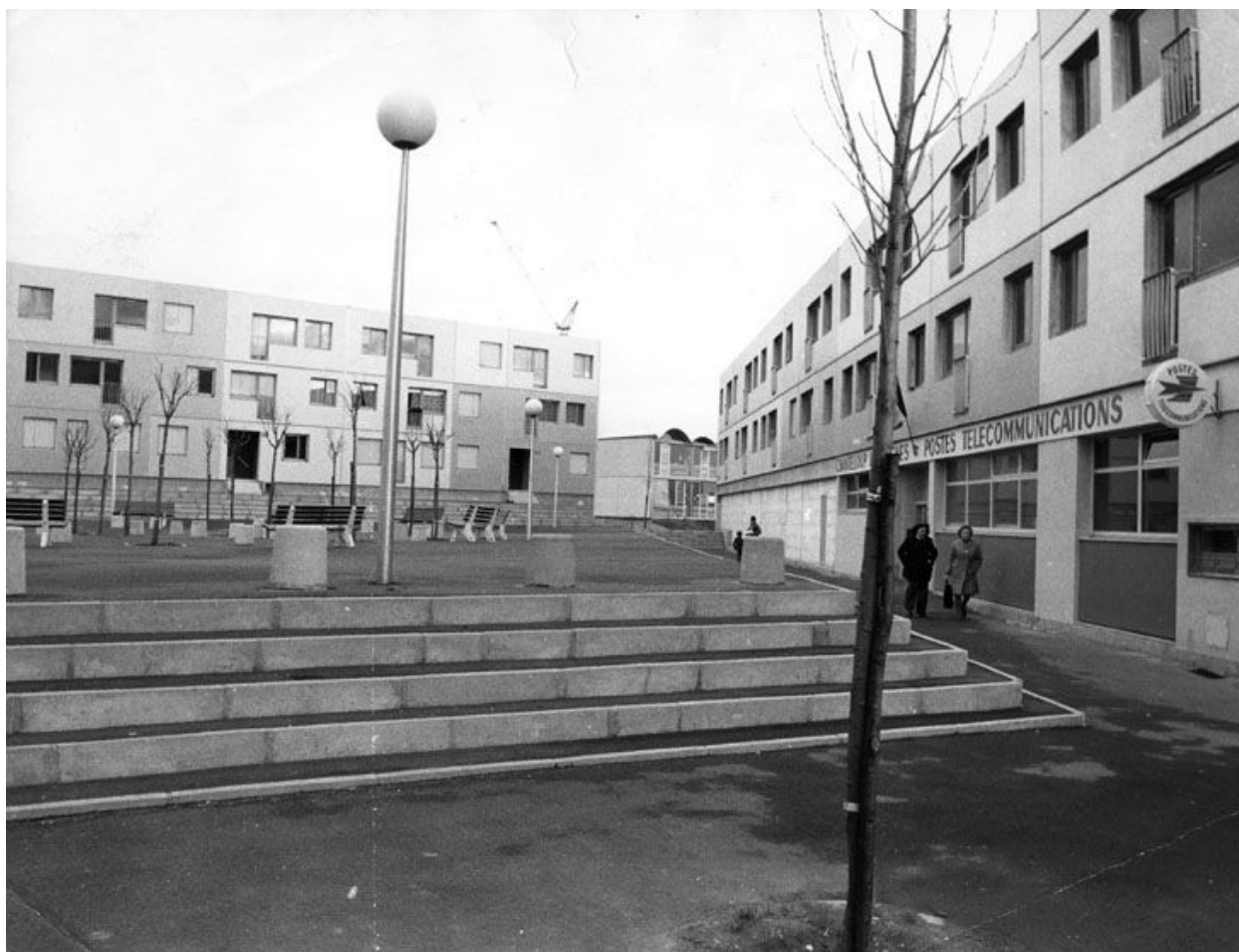
La Noé. La place du Trident et son échelonnement de marches conduisant à un rond-point d'arbres rythmé de bancs publics, au second plan on aperçoit un bâtiment du groupe scolaire Dorgelès. Photographie, 1976. Photographie, 1976. (Mairie de Chanteloup-les-Vignes).
