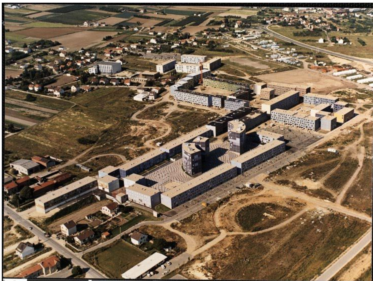
La Noé. Vue aérienne de la partie est de la ZAC durant le chantier. A gauche de l'image, la résidence pour personnes âgées n'est pas encore construite. Au centre en arrière plan (au delà de la Cour Verte), le foyer de travailleurs célibataires de La Lutèce est construit. Photographie, vers 1973. (Cité de l'architecture et du patrimoine, Archives d'architecture du XXe siècle).
