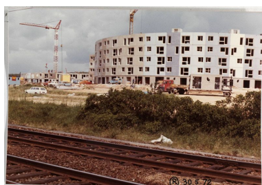
La Noé. Photographie du chantier prise en 1972, depuis les voies de chemin de fer. A droite, un camion transporte un panneau préfabriqué de RDC. (Cité de l'architecture et du patrimoine, Archives d'architecture du XXe siècle). Phot. Laurent Kruszyk, Autr. Louis Rémy Sabattier IVR11_20087800131NUC4A
