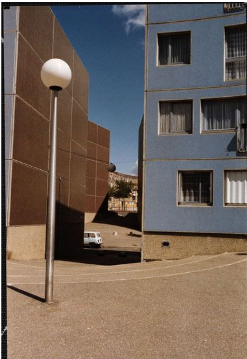
La Noé. Vue du passage entre la place du Bestiaire et au fond celle de l'Hippodrome. Photographie, vers 1978. (Cité de l'architecture et du patrimoine, Archives d'architecture du XXe siècle).
