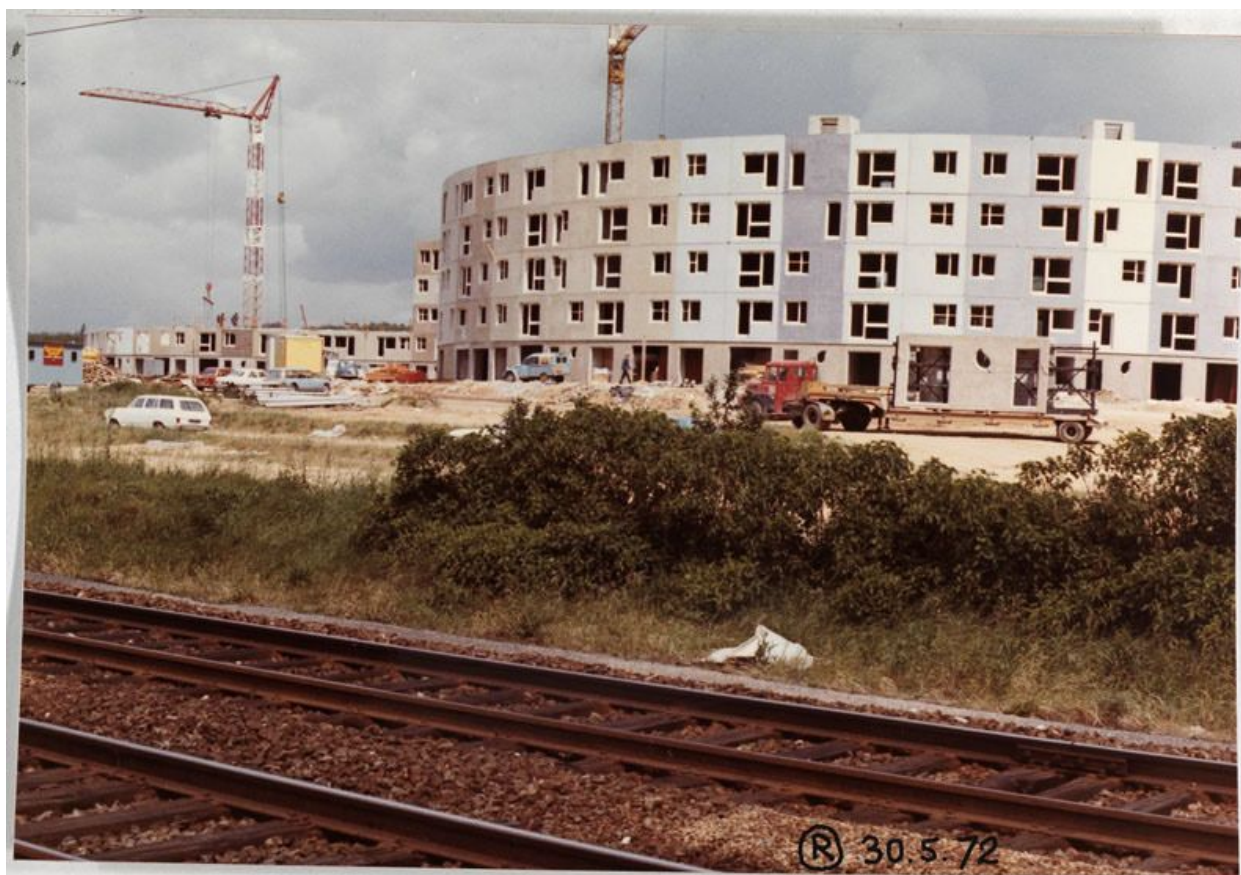
La Noé. Photographie du chantier prise en 1972, depuis les voies de chemin de fer. A droite, un camion transporte un panneau préfabriqué de RDC. (Cité de l'architecture et du patrimoine, Archives d'architecture du XXe siècle).
