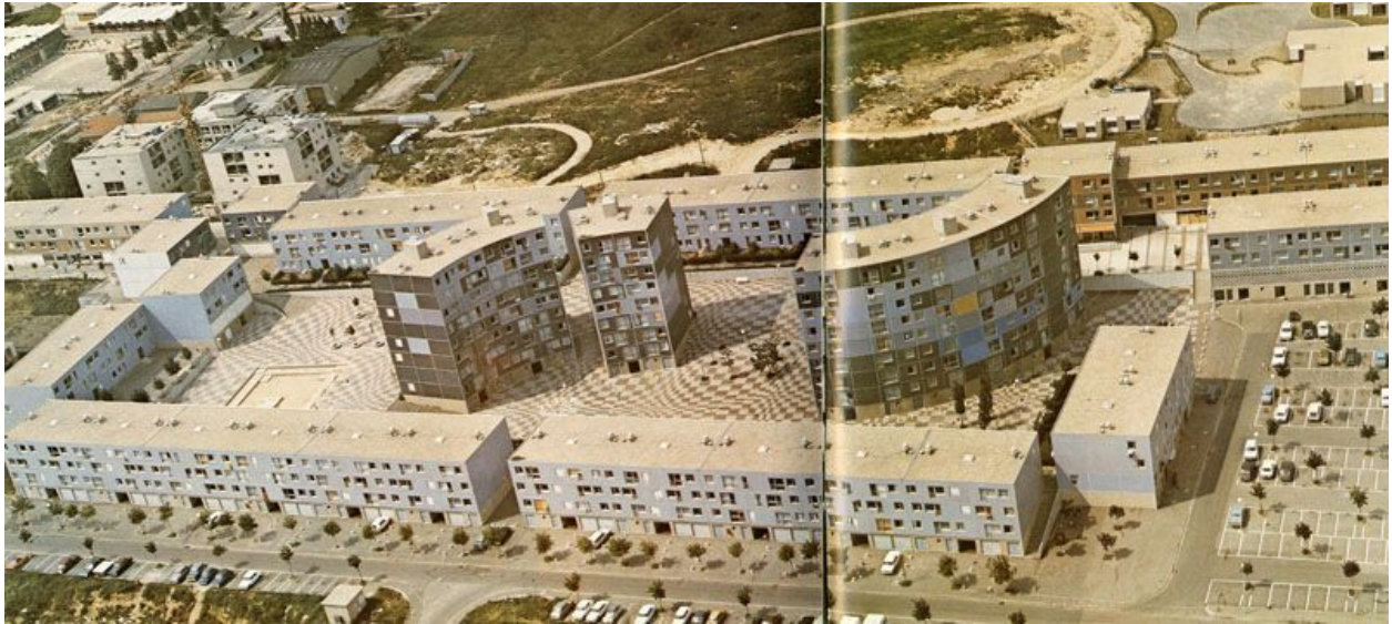
La Noé. Vue aérienne de la place du Béguinage. Le dessin sophistiqué du sol est bien lisible. Le bâtiment tour au centre de la place est aujourd'hui détruit. En haut et à gauche de l'image, la maison de retraite en construction. Photographie, circa 1978. Tiré de : Chanteloup-les-Vignes : quartier la Noé, architecte Émile Aillaud / Emile Aillaud, Fabio Rieti, Gilles Aillaud, Paris : Fayard, 1978.
