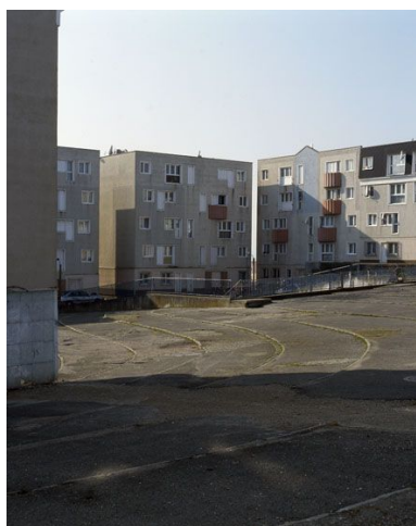
La Noé. Autre vue actuelle de la place de l'Été-Vert. Les degrés formant le sol n'ont pas été entretenus correctement.
