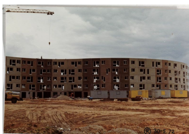
La Noé. Autre vue du chantier. Photographie, 1972. (Cité de l'architecture et du patrimoine, Archives d'architecture du XXe siècle). Phot. Laurent Kruszyk, Autr. Louis Rémy Sabattier IVR11_20087800130NUC4A
