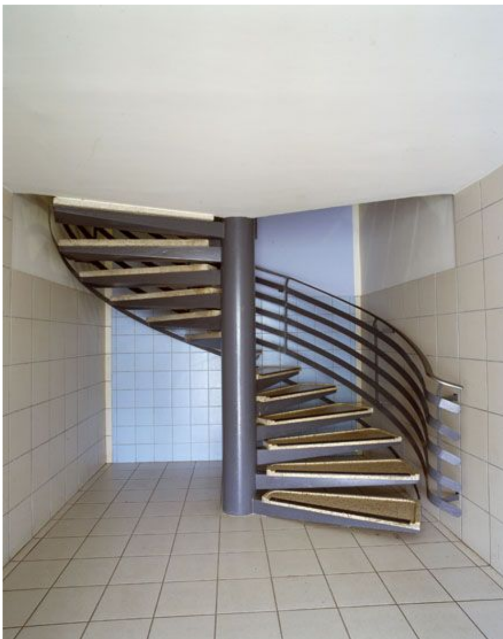
La Noé. Détail d'un escalier en vis en métal et dont les marches sont constituées d'une plaque de granito, desservant les étages (dans un des bâtiments de la place de l'Echauguette).
