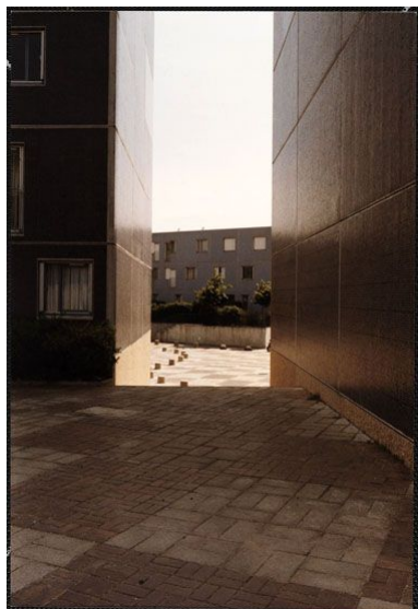
La Noé. Détail d'un étroit passage entre deux bâtiments tours au centre de la place du Béguinage. L'un des deux bâtiments est aujourd'hui détruit. Photographie, vers 1978. (Cité de l'architecture et du patrimoine, Archives d'architecture du XXe siècle). Phot. Laurent Kruszyk, Autr. Louis Rémy Sabattier IVR11_20087800155NUC4A
