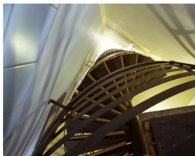
La Noé. Vue en contre plongée de l'escalier montrant comment, circulaire, il s'insère dans la cage d'escalier de plan rectangulaire. Phot. Philippe Ayrault IVR11_20087800230XA
