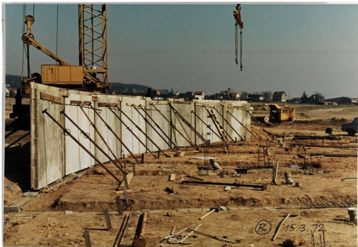
La Noé. Photo du chantier en 1972. On observe la mise en place de panneaux préfabriqués en RDC. (Cité de l'architecture et du patrimoine, Archives d'architecture du XXe siècle).
