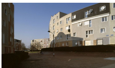
La Noé. Vue d'ensemble actuelle de la place des Quatre-Vents. Les façades ont été totalement transformées par l'isolation extérieure. Les fenêtres ont été changées.
