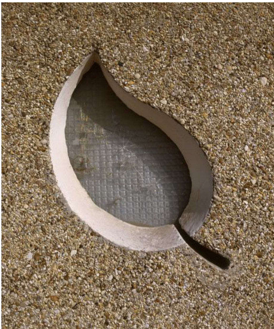
La Noé. Détail d'une ouverture en forme de feuille dans les panneaux de façade de certains rez-de-chaussée. Ces ouvertures permettent l'aération de locaux communs.
