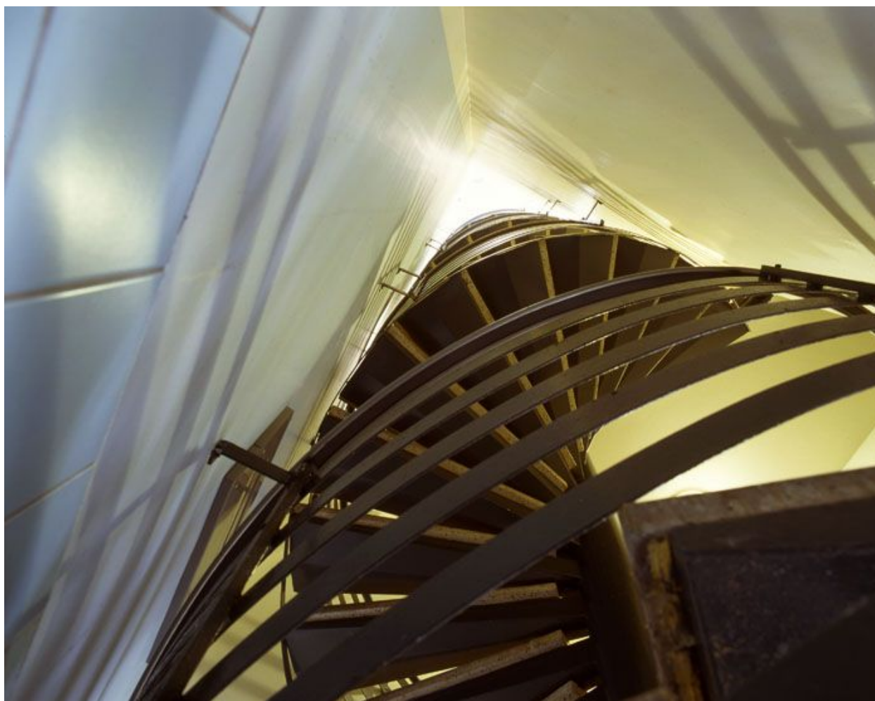
La Noé. Vue en contre plongée de l'escalier montrant comment, circulaire, il s'insère dans la cage d'escalier de plan rectangulaire.
