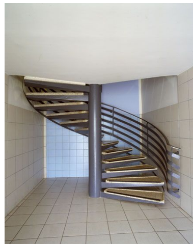
La Noé. Détail d'un escalier en vis en métal et dont les marches sont constituées d'une plaque de granito, desservant les étages (dans un des bâtiments de la place de l'Echauguette). Phot. Philippe Ayrault IVR11_20087800228XA
