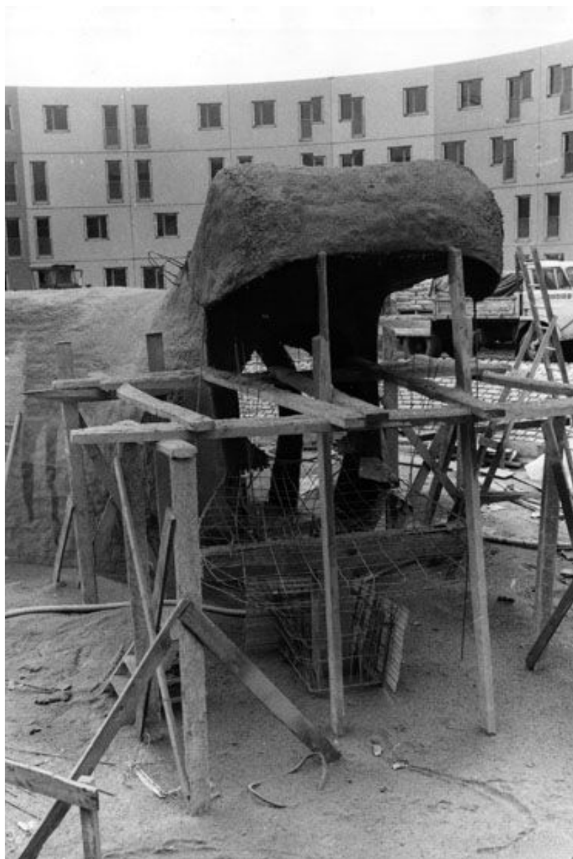
La Noé. Photographie du chantier prise le 17 avril 1973, de la place du Bestiaire. Au premier plan, l'hippopotame vu de face dont seule la partie supérieure de la gueule est façonnée, encore supportée par une armature de bastings. Le ferrailage de la partie inférieure de la gueule est en place. (Mairie de Chanteloup-les-Vignes).
