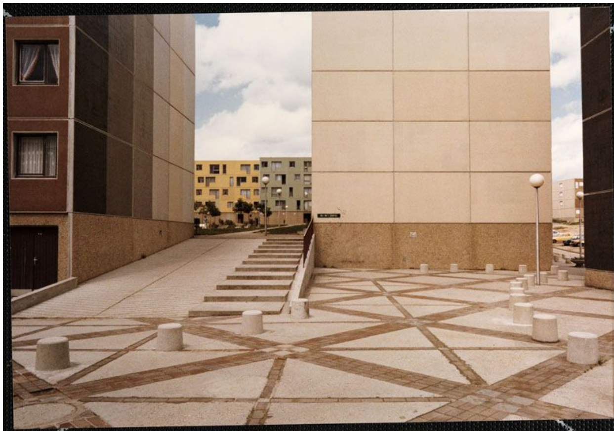
La Noé. Vue du passage entre la place des Arcades et la cour Verte. Photographie, vers 1978. (Cité de l'architecture et du patrimoine, Archives d'architecture du XXe siècle).
