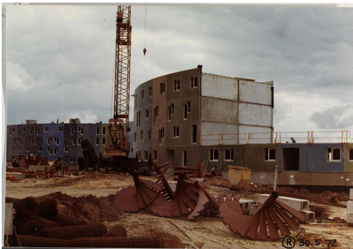
La Noé. Photographie du chantier en 1972. Bâtiment courbe en construction au second plan ; au premier plan, escaliers pré-fabriqués stockés au sol. (Cité de l'architecture et du patrimoine, Archives d'architecture du XXe siècle).
