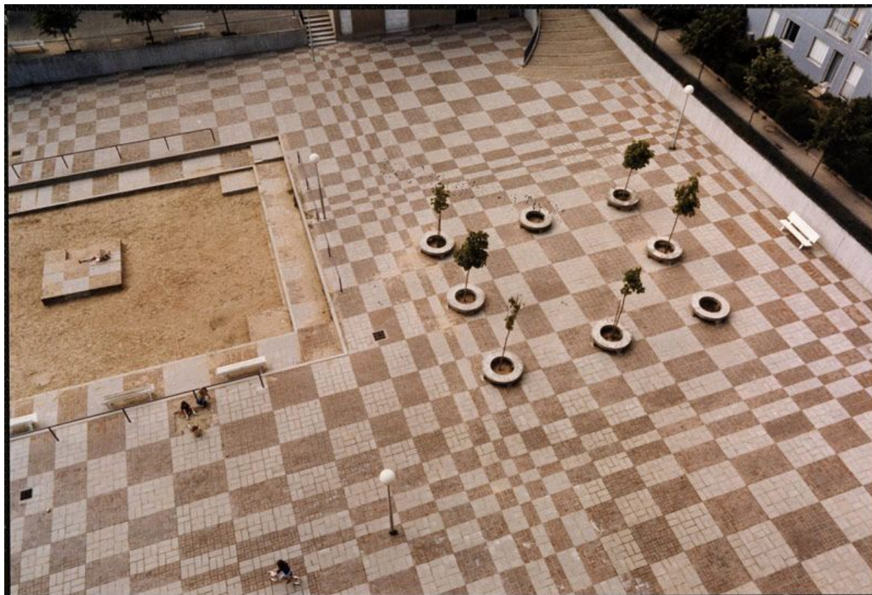
La Noé. Détail du traitement du sol fait de dalles de ciment et de briques formant un motif géométrique cynétique composé par Ewa Bruckalska. Photographie, vers 1978. (Cité de l'architecture et du patrimoine, Archives d'architecture du XXe siècle).
