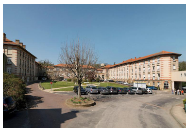
Troisième unité de soin construite sur le site dite pavillon Fontenay, cour délimitée par ses trois corps de logis constitutifs à l'est, vue générale prise de face Phot. Jean-Bernard Vialles IVR11_20129100111NUC4A
