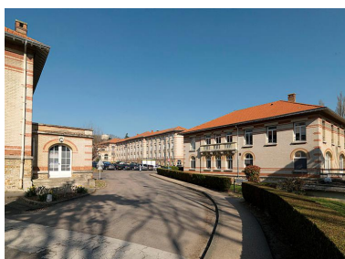
Entrée de l'établissement avec, sur la gauche, la troisième unité de soin construite sur le site
