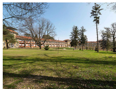
Première unité de soin construite sur le site, ensuite affectée aux hommes, dite pavillon Despeaux-Rubod, élévation méridionale, corps de logis central et corps de logis latéral droit, vue d'ensemble prise de trois-quarts gauche. Phot. Jean-Bernard Vialles IVR11_20129100116NUC4A
