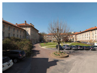
Troisième unité de soin construite sur le site dite pavillon Fontenay, cour délimitée par ses trois corps
