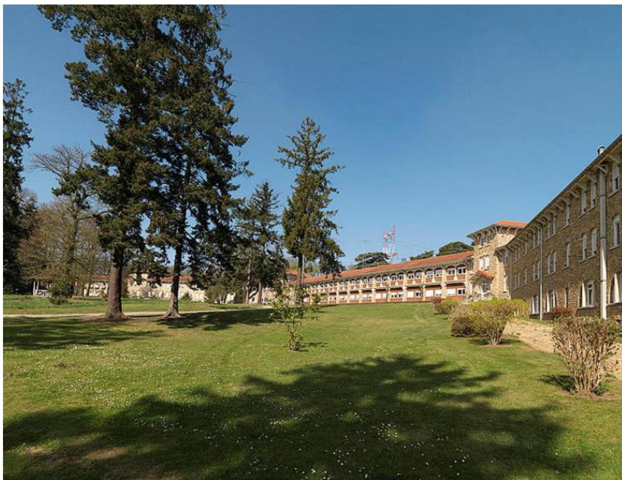
Première unité de soin construite sur le site, ensuite affectée aux hommes, dite pavillon Despeaux-Rubod, élévation méridionale prise depuis le flanc droit, vue générale.
