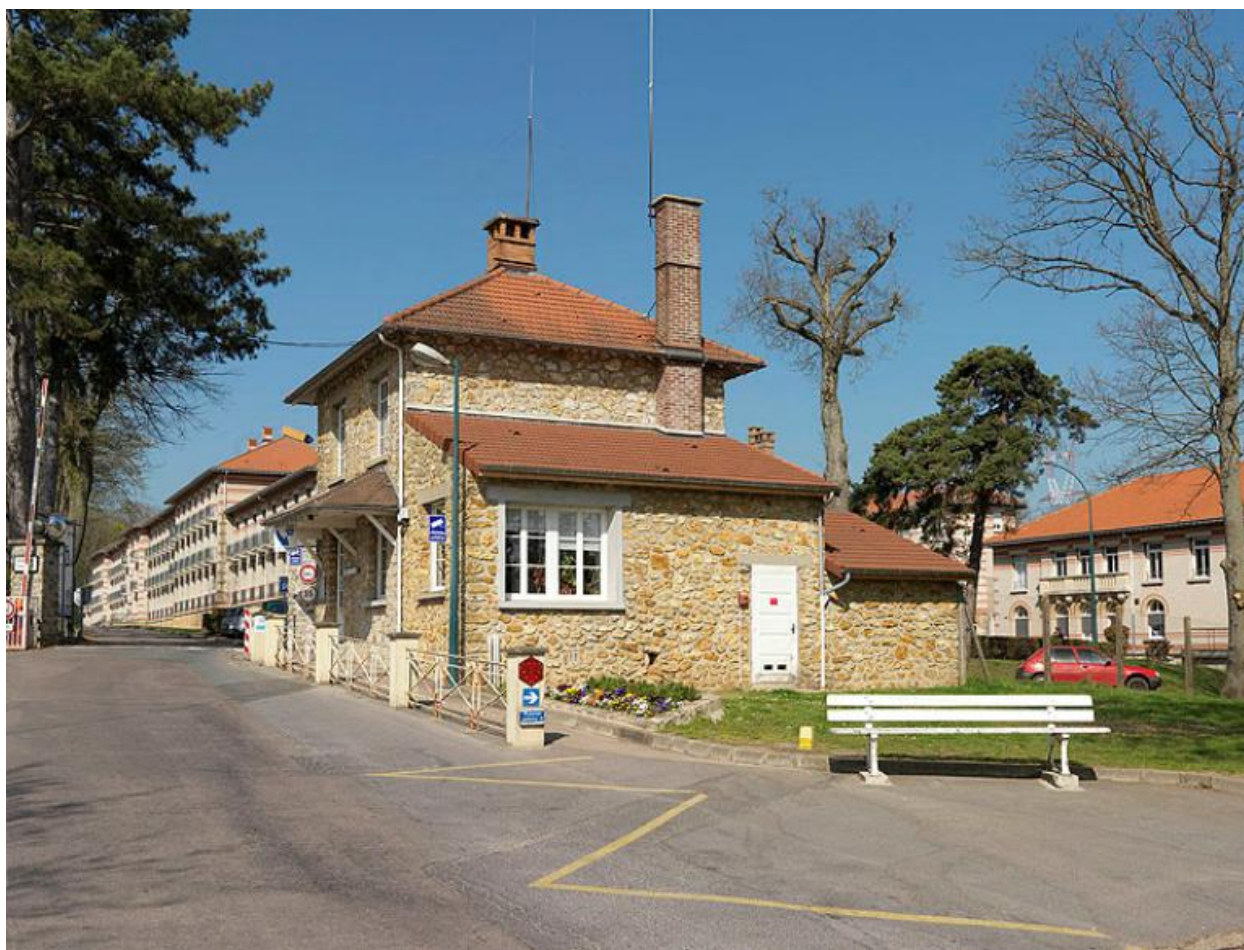
Pavillon d'entrée avec, au second plan, la troisième unité de soin construite sur le site dite pavillon Fontenay, corps de logis méridional, élévations sud, vue d'ensemble prise en enfilade.
