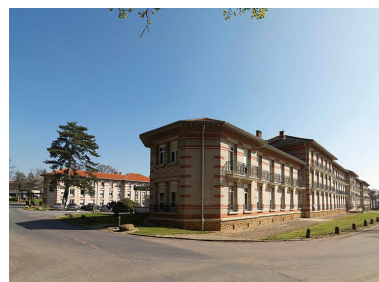
Troisième unité de soin construite sur le site dite pavillon Fontenay, corps de logis méridional, élévation sud, vue prise depuis le flanc gauche. Phot. Jean-Bernard Vialles IVR11_20129100107NUC4A
