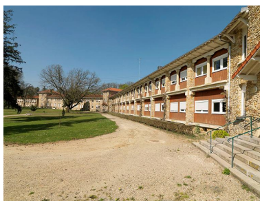
Première unité de soin construite sur le site, ensuite affectée aux hommes, dite pavillon Despeaux-Rubod, élévation méridionale, corps de logis central et corps de logis latéral droit, vue d'ensemble prise en enfilade depuis le flanc droit. Phot. Jean-Bernard Vialles IVR11_20129100115NUC4A
