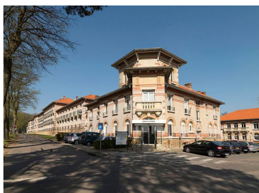
Troisième unité de soin construite sur le site dite pavillon Fontenay, corps de logis méridional, élévation sud, vue prise en enfilade depuis le flanc droit. Phot. Jean-Bernard Vialles IVR11_20129100106NUC4A
