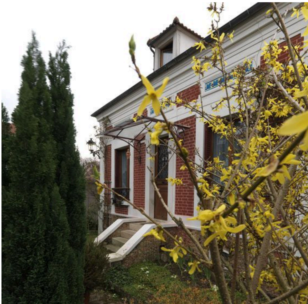
Vue d'ensemble de la façade.
