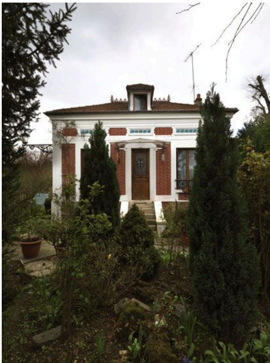
Vue d'ensemble de la façade et du jardin.
