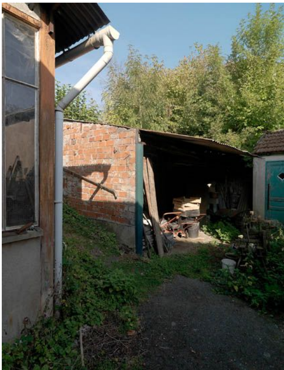
Façade orientale de l'atelier et appentis construit à l'arrière de la maison.
