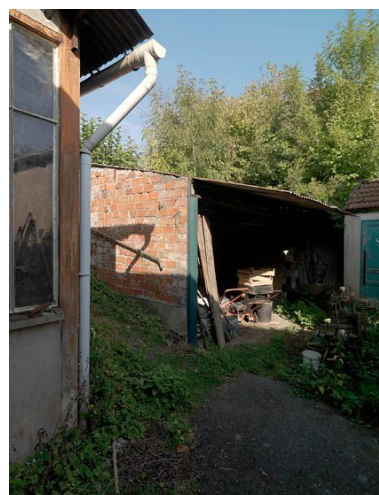
Façade orientale de l'atelier et apprentis construit a l'arriere de la maison. Phot. Philippe Ayrault IVR11_20097701358NUC4A
