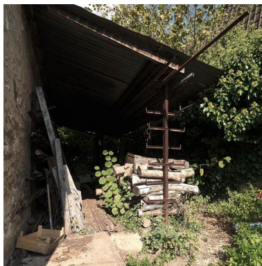
Portants métalliques servant au stockage des barres de fer à façonner.
