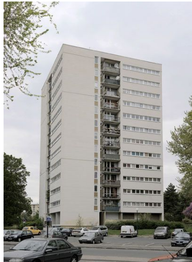
Vue générale de la tour N. Phot. Jean-Bernard Vialles IVR11_20109100112NUC4A
