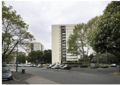
Les tours M et N depuis l'avenue Saint-Marc. Phot. Jean-Bernard Vialles IVR11_20109100111NUC4A
