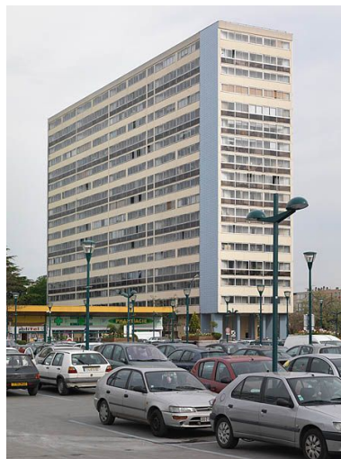
Une des barres R+16 réhabilitée dans les années 1980 pour l'isolation : les loggias ont toutes été fermées et certaines parties de la façade ont été recouvertes d'isolant bleu. Phot. Stéphane Asseline IVR11_20119100156NUC4A
