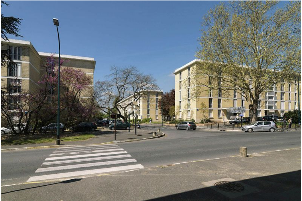
Vue d'ensemble des barres J, D et E.
