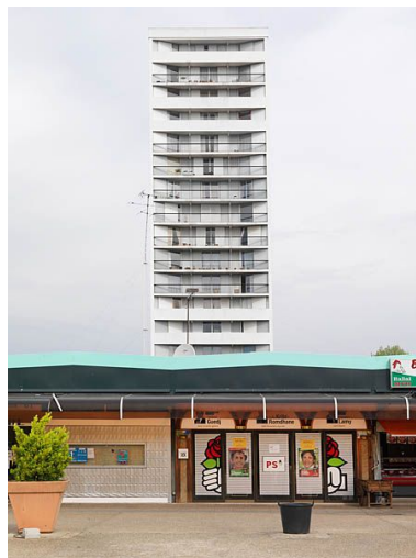
Vue d'une des trois barres R+16 située rue des Canadiens, depuis le centre commercial Les Franciades. Phot. Stéphane Asseline IVR11_20119100155NUC4A
