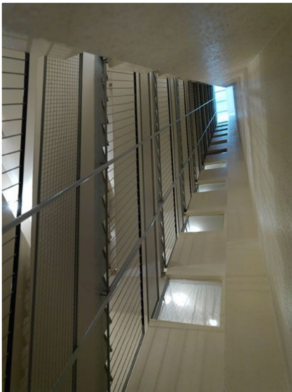
La cage d'escaliers de la tour N.
