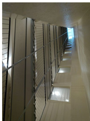
La cage d'escaliers de la tour N.
