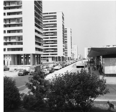
Les barres P, Q et R depuis l'avenue Saint-Marc. Photographie, 1966. (Ministère de l'Ecologie, MRU 43741008) Phot. MEEDDAT-DICOM IVR11_20109100161NUC1B
