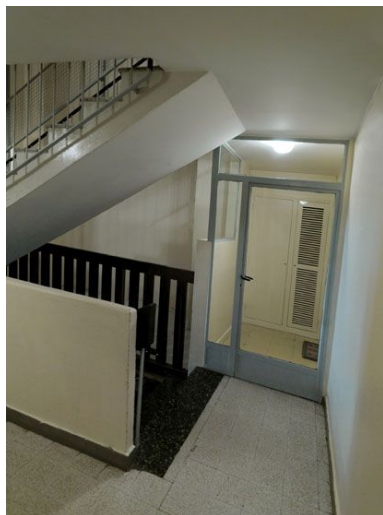
Palier de la tour N. Phot. Jean-Bernard Vialles IVR11_20109100115NUC4A
