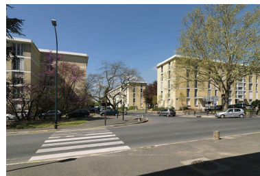
Vue d'ensemble des barres J, D et E. Phot. Jean-Bernard Vialles IVR11_20109100022NUC4A
