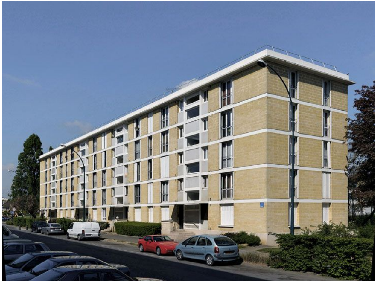
Vue générale de la barre E.
