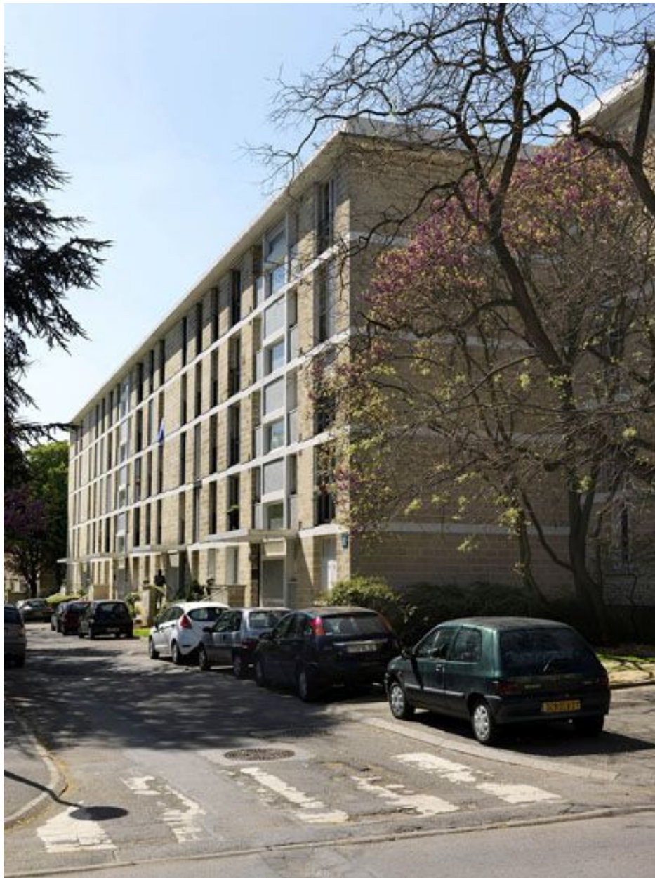
Vue générale de la barre J.
