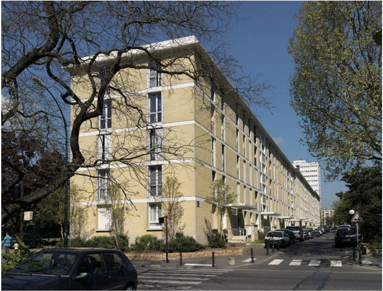
Vue générale de la barre D.
