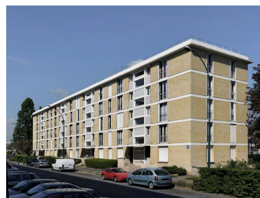
Vue générale de la barre E. Phot. Jean-Bernard Vialles IVR11_20109100017NUC4A
