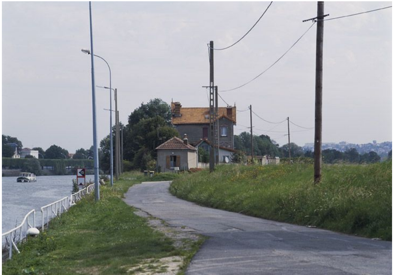
Maisons situées entre le chemin de contre-halage et le chemin rural n° 12 du Bac d'Ablon, près du barrage d'Ablon.
