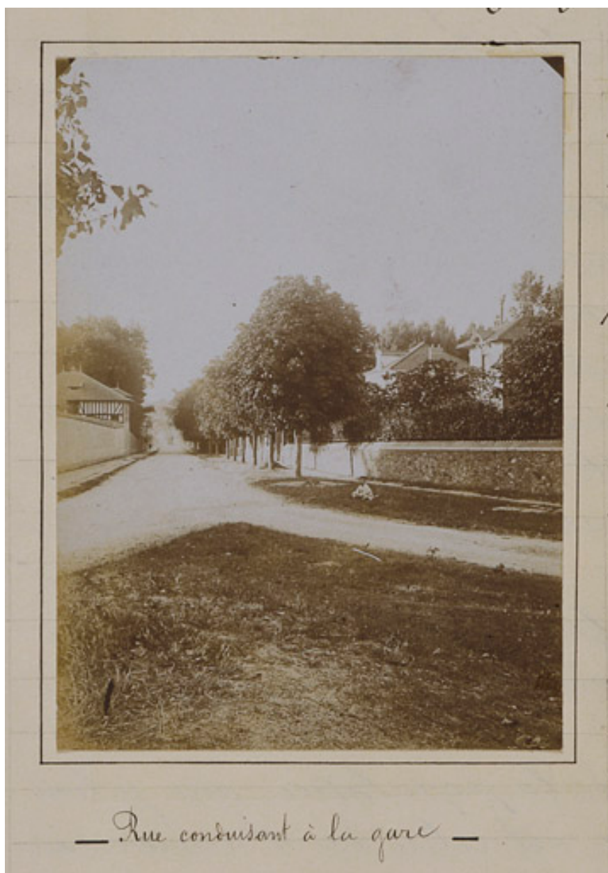
Vue de la rue conduisant à la gare (rue Pierre-Marín), extraite de la monographie communale rédigée en 1899 par l'instituteur Anatole Roy. (AD Essonne)
