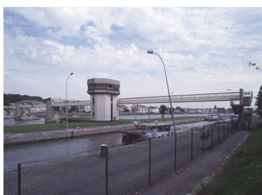
Le barrage d'Ablon ; à droite, l'écluse de Vigneux ; au centre, la cabine de manoeuvre automatique. Phot. Stéphane Asseline IVR11_20079101403XA
