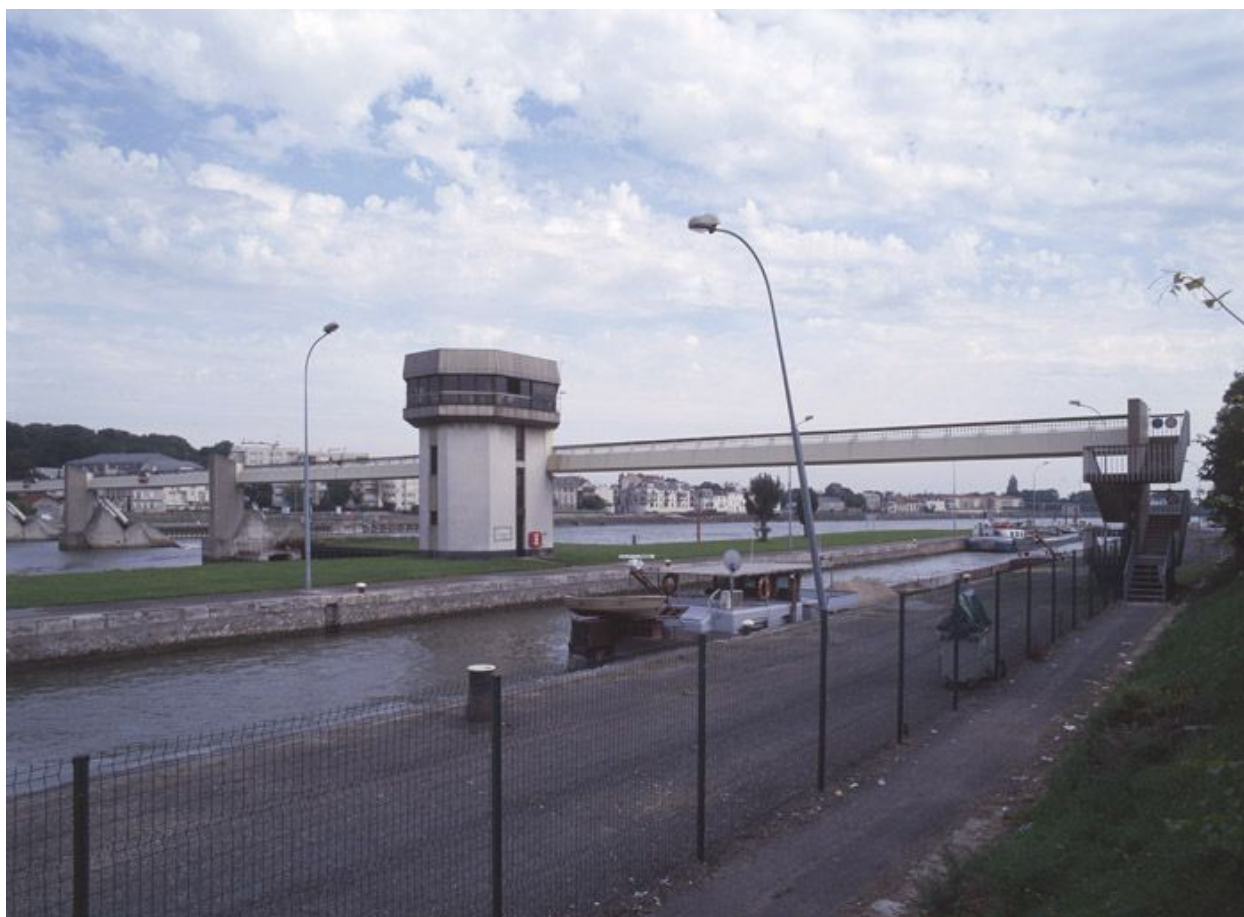
Le barrage d'Ablon ; à droite, l'écluse de Vigneux ; au centre, la cabine de manoeuvre automatique.
