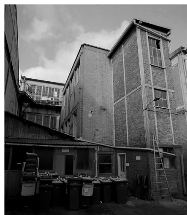
Vue de l'arrière des ateliers. Phot. Jean-Bernard Vialles IVR11_20019300141X
