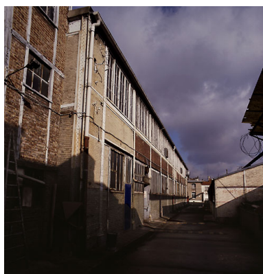
Vue des ateliers. Phot. Jean-Bernard Vialles IVR11_20019300138XA
