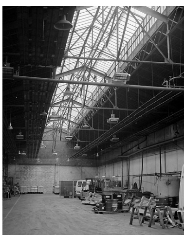
Vue intérieure de l'atelier est. Phot. Jean-Bernard Vialles IVR11_20019300144X
