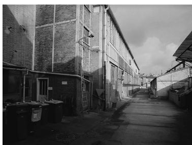
Vue des ateliers et de la cantine. Phot. Jean-Bernard Vialles IVR11_20019300140X
