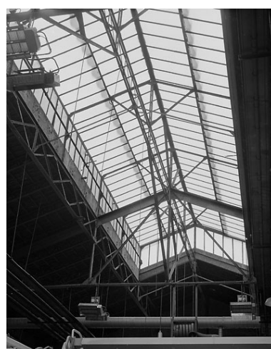
Verrière de l'atelier est. Phot. Jean-Bernard Vialles IVR11_20019300145X
