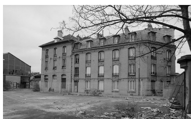
Vue des bureaux et des logements du personnel. Phot. Jean-Bernard Vialles IVR11_20019300142X
