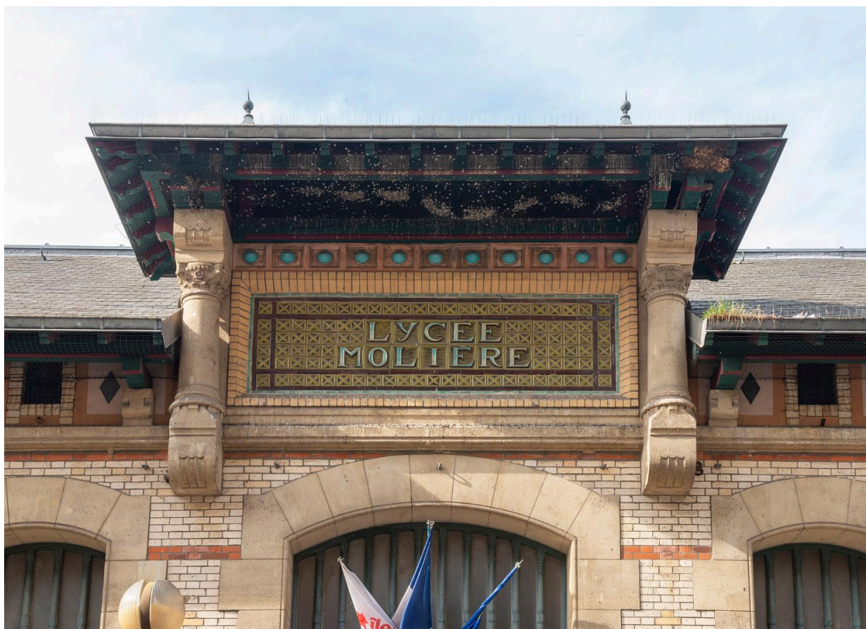
Détail du fronton du lycée Molière, sur la rue du Ranelagh.
