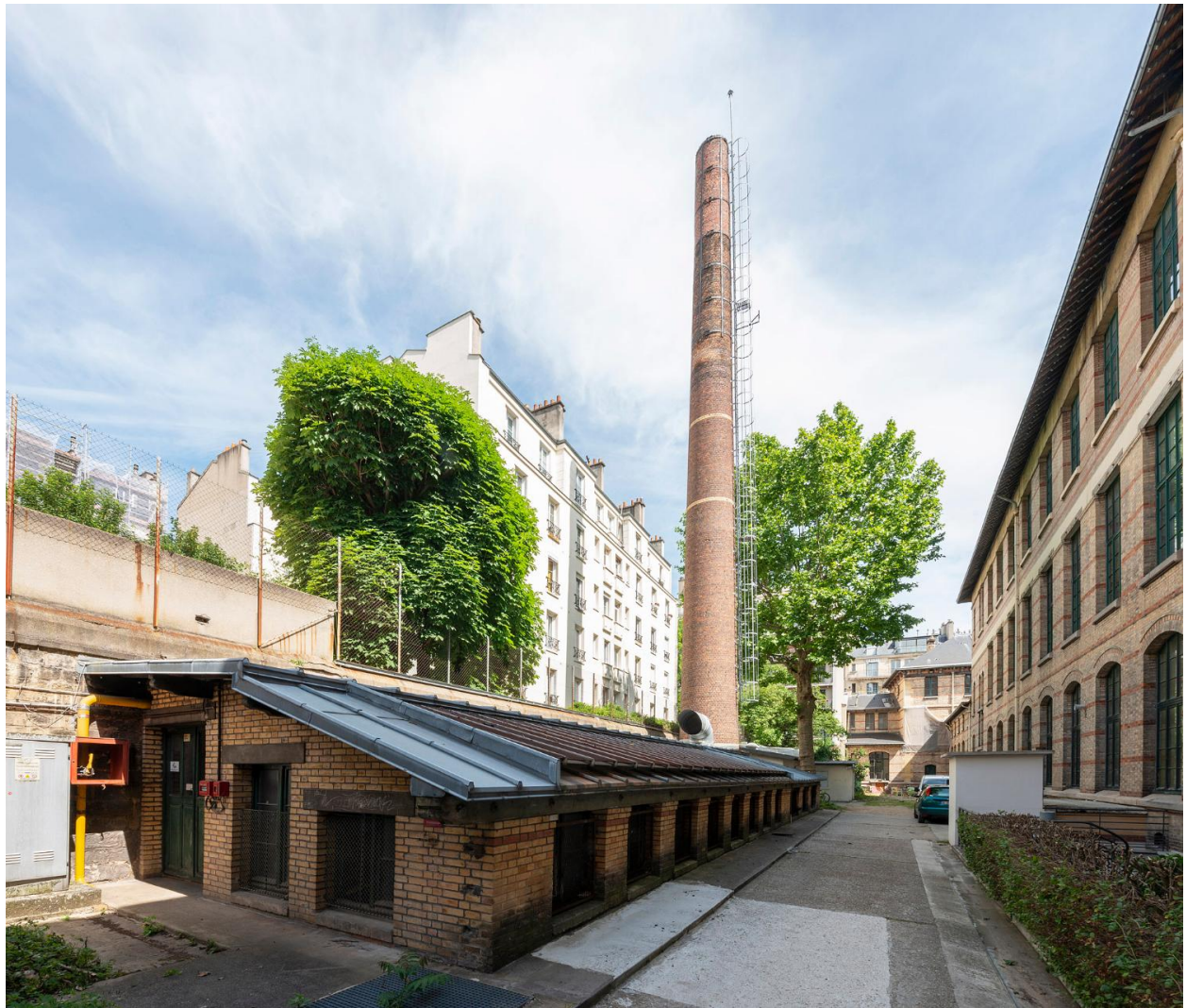
La chaufferie du lycée Molière. Comme le reste des bâtiments, elle est en briques blanches de Chartres, qui s'harmonisent avec les soubassements en pierre d'Euville.
