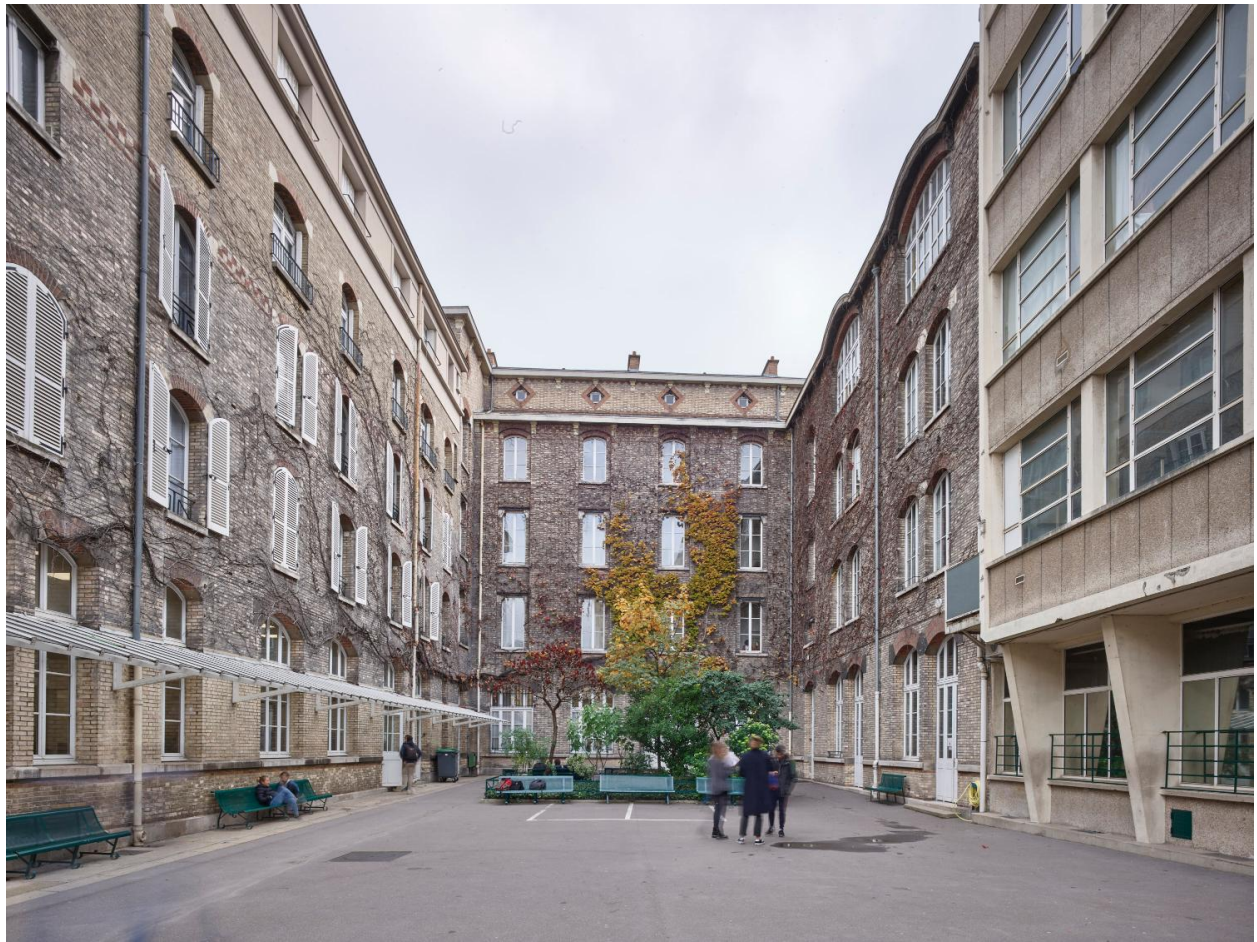
La cour du lycée Victor-Hugo (Paris, 4e). A droite, l'extension construite par l'architecte Henri Ducoux dans les années 1950, en béton armé.
