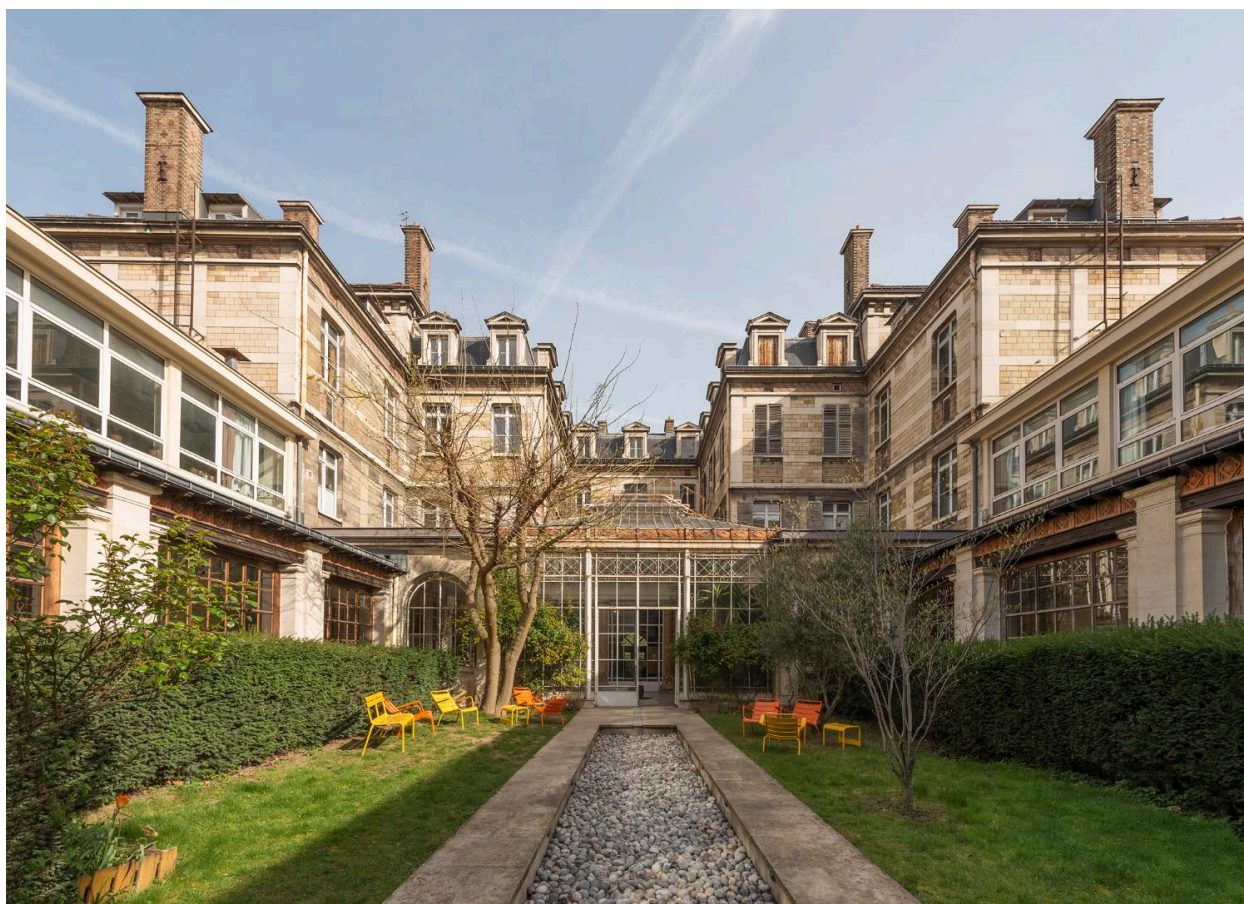
Le jardin d'hiver du lycée Montaigne, tout en transparence, vu depuis l'extérieur.
