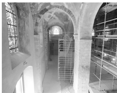
Le collatéral sud de la nef, vu depuis le transept. Photographie prise en 2005, pendant la restauration de la nef. Phot. Stéphane Asseline IVR11_20057700279X
