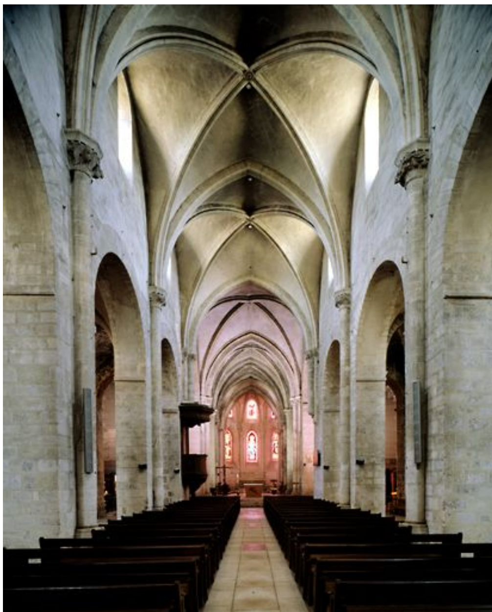
Vue intérieure, depuis l'entrée.
