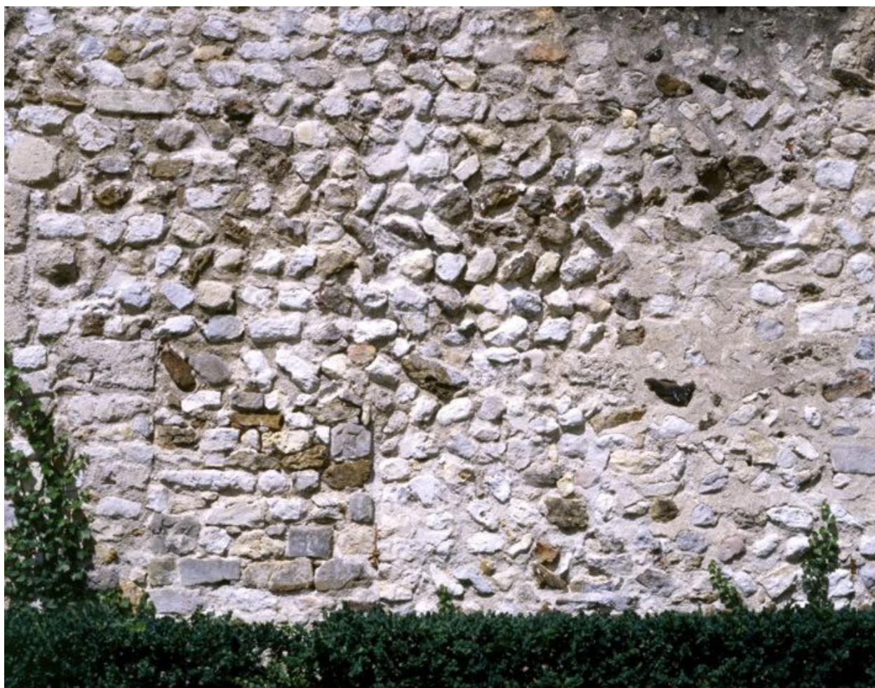
Détail de la maise en oeuvre du mur pignon du bras sud du transept.
