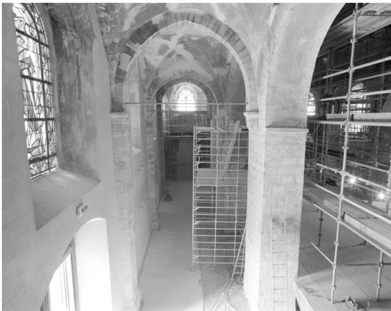
Le collatéral sud de la nef, vu depuis le transept. Photographie prise en 2005, pendant la restauration de la nef.
