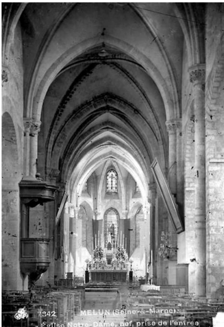
Vue intérieure, depuis l'ouest. Photographie. (Médiathèque de l'architecture et du patrimoine, archives photographiques. MH 00007342)
