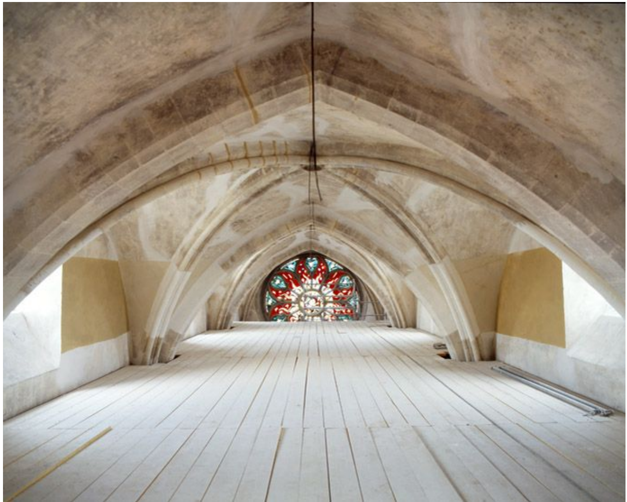
Les voûtes de la nef. Cliché pris pendant la restauration de 2005.
