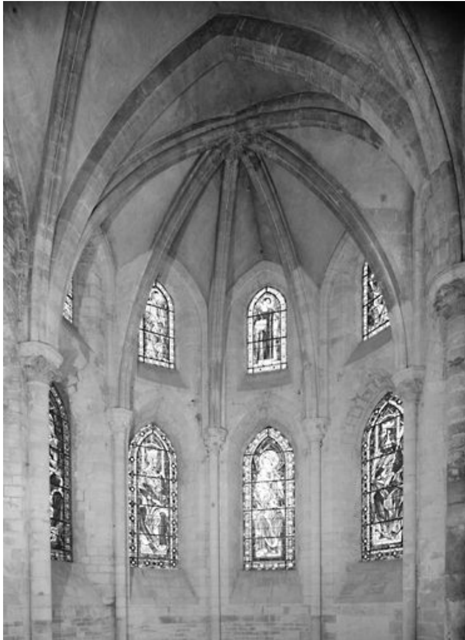
L'abside : vue intérieure.
