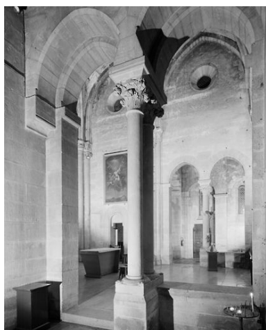
Travées droites du chœur, vues depuis le collatéral sud. Phot. Stéphane Asseline IVR11_20027700623V
