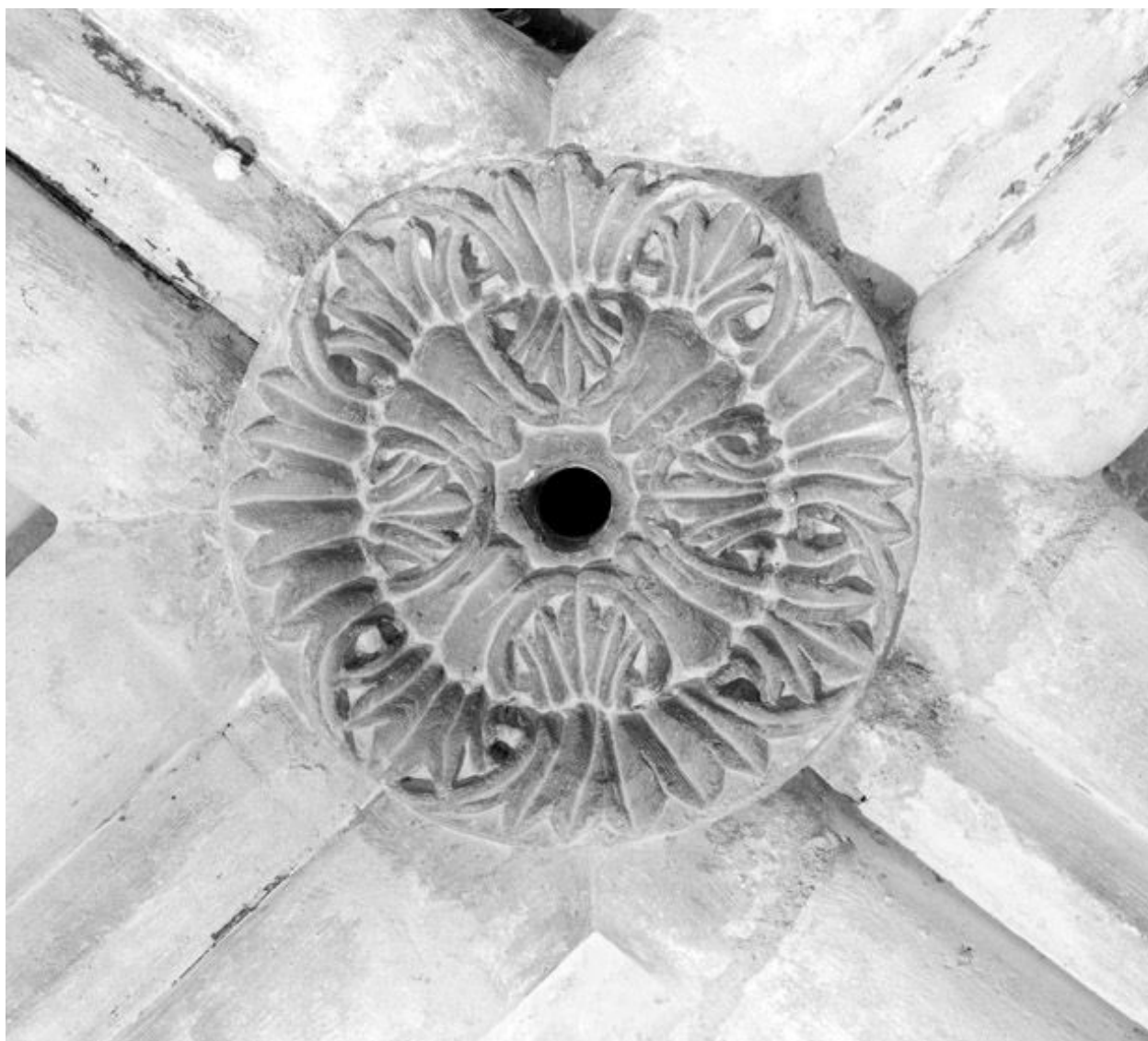
Clé de voûte de la nef, à décor végétal, vue depuis un échaffaudage en 2005.
