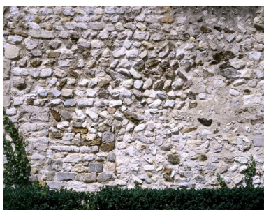
Détail de la maïse en oeuvre du mur pignon du bras sud du transept. Phot. Stéphane Asseline IVR11_20077700020XA
