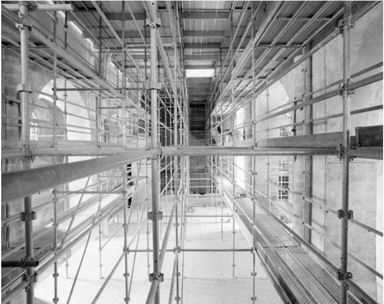
Restauration de la nef (2005) : l'échaffaudage intérieur.
